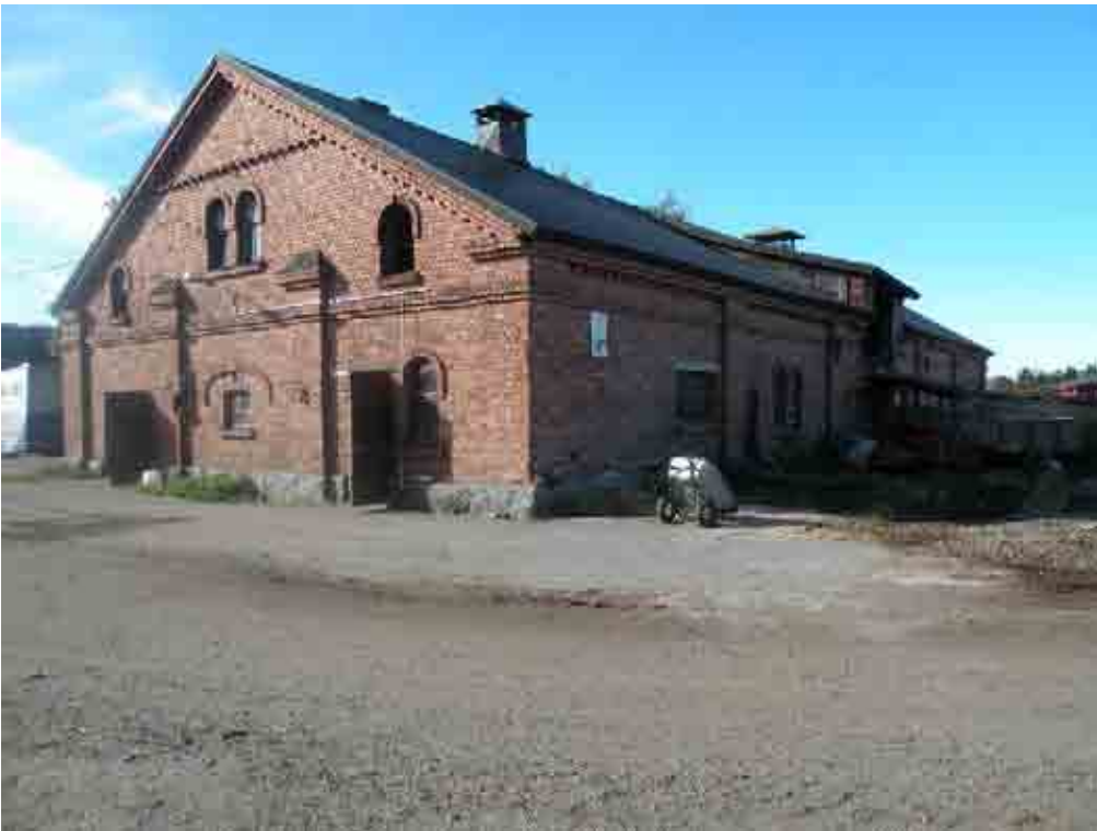
Kuva 10. Tampere Sorila (Sorrila) Kulkaan tiilinen navetta 1900-luvun alusta. Kuvattu koillisesta. (DSCN2036_44)
