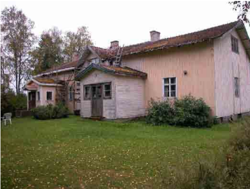
Kuva 33. Palo (Pahlo). Nykyisen Utukan tilan päärakennus. Kuvattu koillisesta. (KYY 53: 25, DSCN0018_84)
