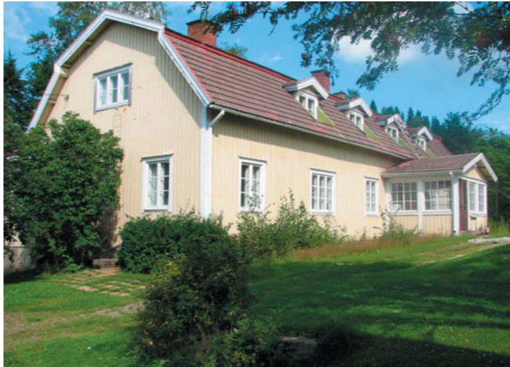
Kuva 8: Kovapään tilakeskuksen päärakennus.
