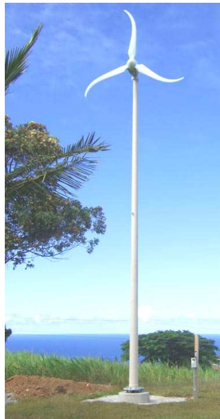
Kuva 6.3: Vaaka-akselinen Skysteam pientuulivoimala. [61]
