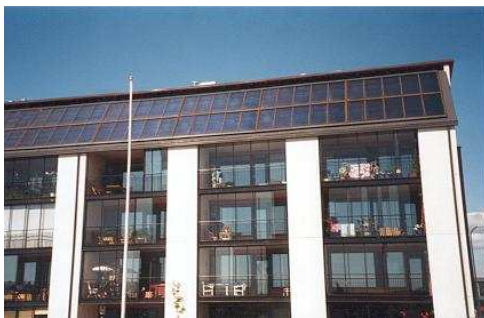
Kuva 2.2: Kohde 7, As Oy Helsingin Auringonkukka. Osaksi vesikattoa integroituilla aurinkolämpökeräimillä tuotetaan lämmintä käyttövedettä. [11]
