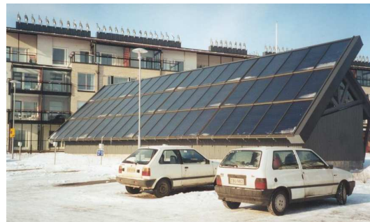
Kuva 2.3: Kohde 5, Helsingin Asumisoikeus Oy. Asuntojen käyttövedestä osa lämmitetään huoltorakennukseen integroiduilla aurinkolämpökeräimillä. [11]
