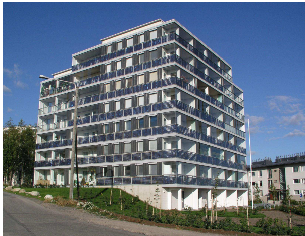
Kuva 2.4: Kohde 22, As Oy Helsingin Salvia. Aurinkosähköä hyödyntävä kerrostalo, jossa aurinkosähkökennot on integroitu parvekkeiden lasikaiteisiin. [26]
