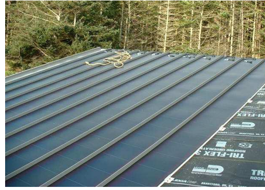
Kuva 4.23: New England Metal Roof:n peltikattoon integroitu ohutkalvolaminaatti. [15]
