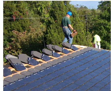
Kuva 4.21: Atlantis Energy Systems:n valmistamia Sunslates aurinkokattotiiliä [59].
