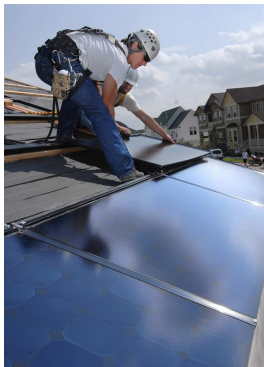
Kuva 4.19: Aurinkokattopaneelien asennusta Solar Decathlon kilpailussa [63].
