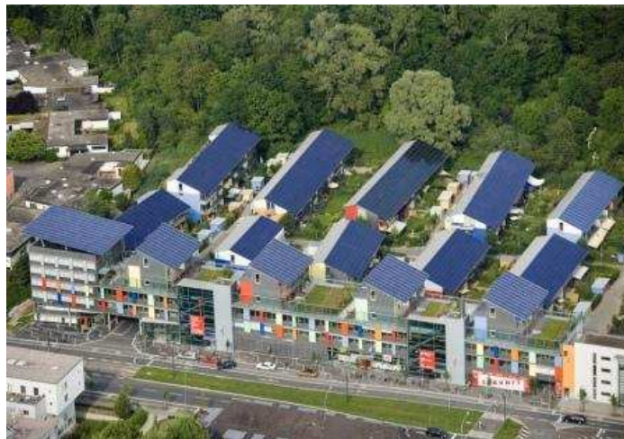
Kuva 2.5: Freiburg Solar Siedlung, Saksa. Etäreunalla on Sonnenschiff liikekeskus ja sen takana plusenergiarivitaloja. Etelään suunnatuille katoille asennetut aurinkosähköpaneelit tuottavat sähköä yli oman tarpeen ja asukkaat myyvät ylijäämänsä yleiseen sähköverkkoon. [8]
