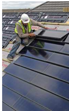
Kuva 4.20: Solarcentury:n valmistamia C21e Solar Tiles aurinkokattotiiliä [7].
