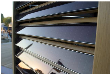
Kuva 4.27: Technische Universität Darmstadt, Saksa. Kaihtimiin integroidu aurinkokennoja. [64]
