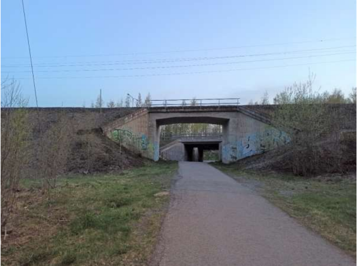
Kuva 7. Alikulku liito-oravan mahdollisen kulkuyhteyden kohdalla.
