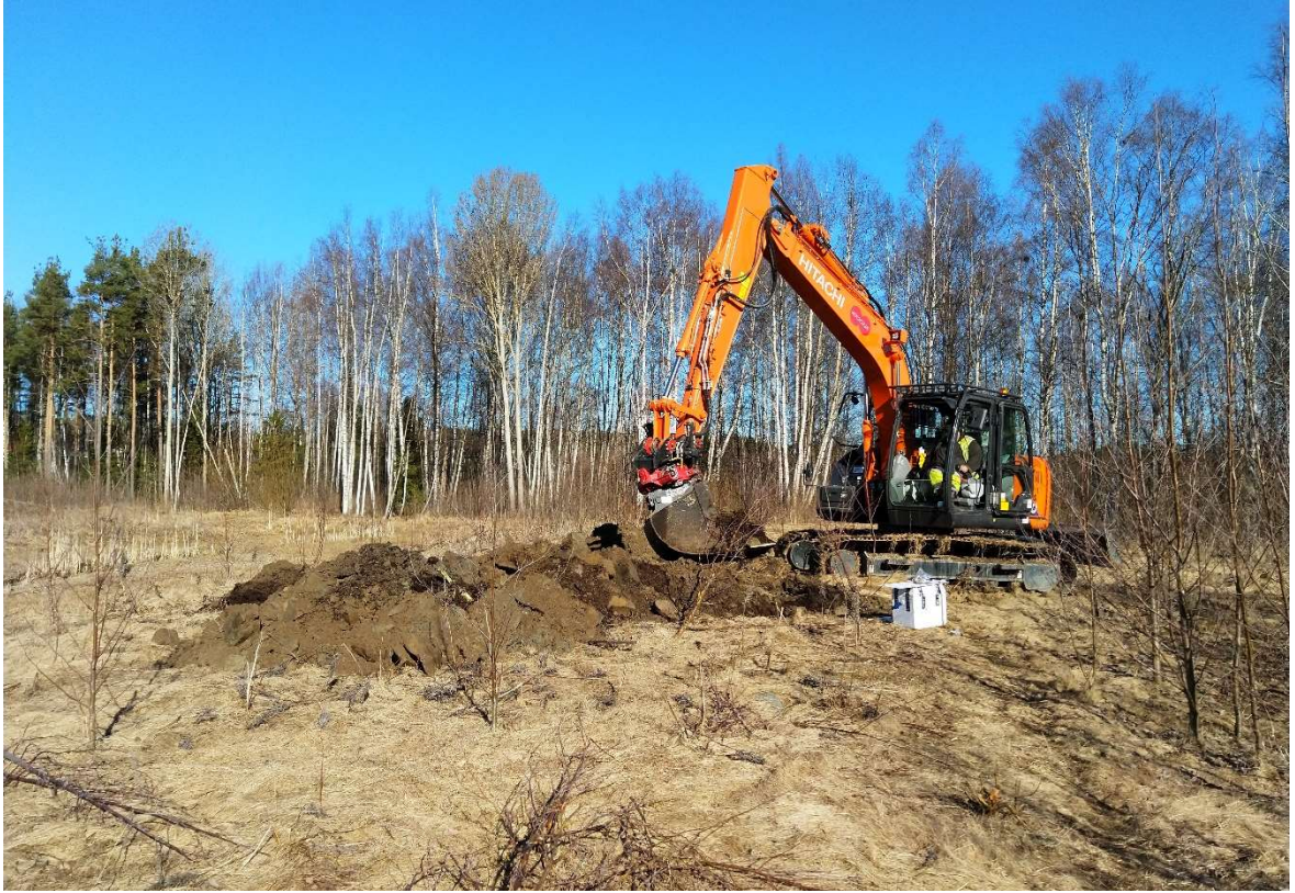
Kuva 5. Koekuopan FCG3 kaivua. Koekuopat 3 ja 4 sijaitsivat alueelle rakennetun hulevesi- / kosteikkoalueen reunalla matalien kumpareiden päällä. Näillä kohdin paikalle on tuotu täyttömaata ja perusmaa (turve) alkoi vasta 1,5 – 1,6 m syvyydellä. FCG3 ja FCG4 alueella todettiin vähäisiä määriä yksittäisiä jätteitä luonnonmaakerroksessa (FCG3) tai täyttömaassa (FCG4). Kuva on otettu pohjoisen suuntaan. Taustalla näkyvällä puustoalueella ei todettu jätteitä.
