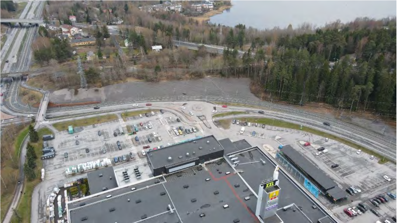
Kuva 9. Tutkimusalueen eteläinen pysäköintialue 10.5.2021.
