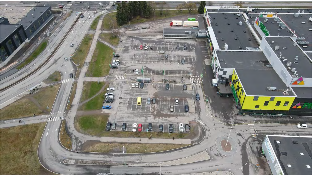
Kuva 4. Alueen pohjoisosaa 10.5.2021. Unionin huoltoasema on sijainnut aikanaan kuvan alaosan pysäköintialueella.
