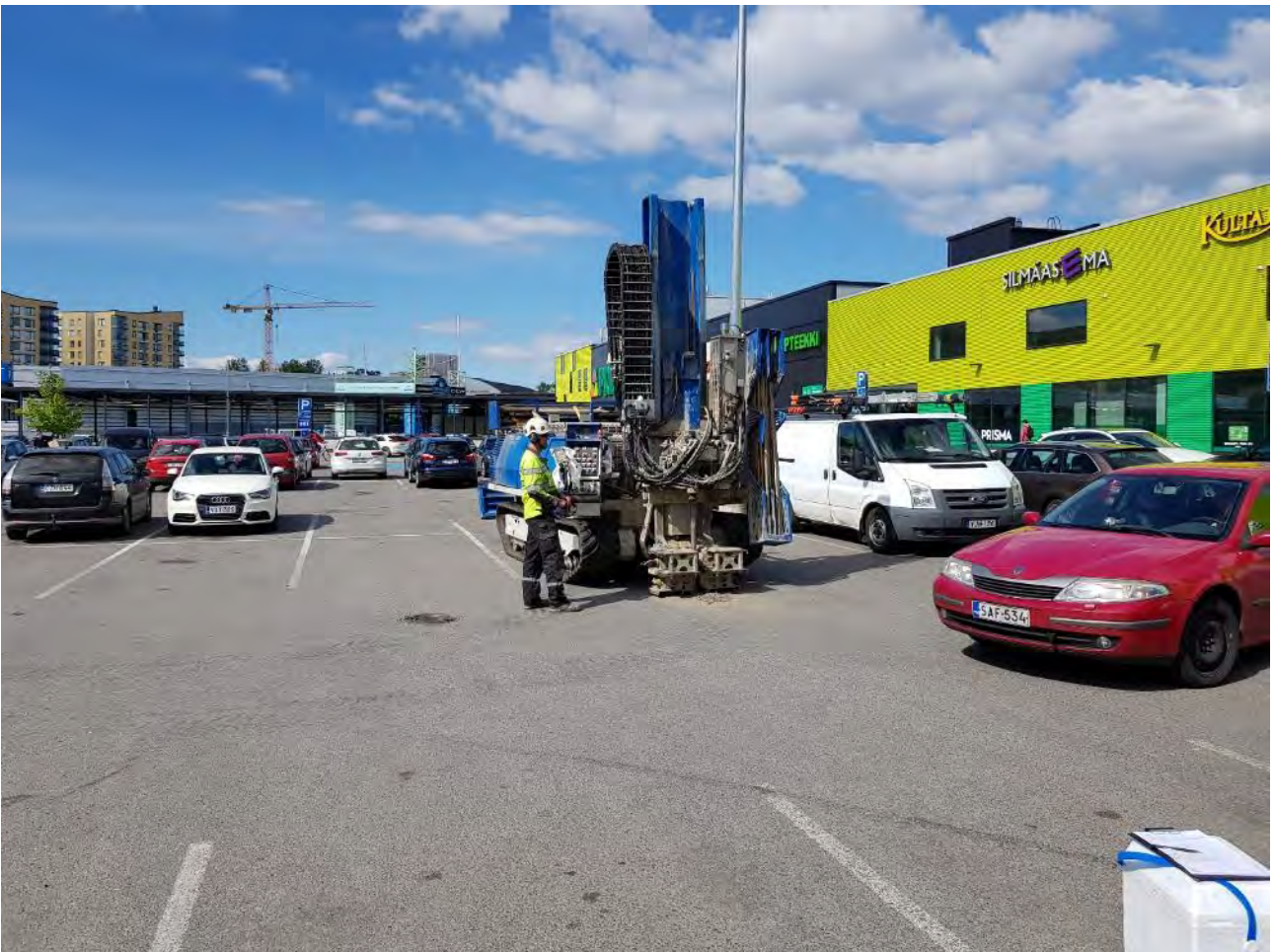
Kuva 10. Kairausnäytteenotto pisteen RKP12 kohdalla 1.6.2021.
