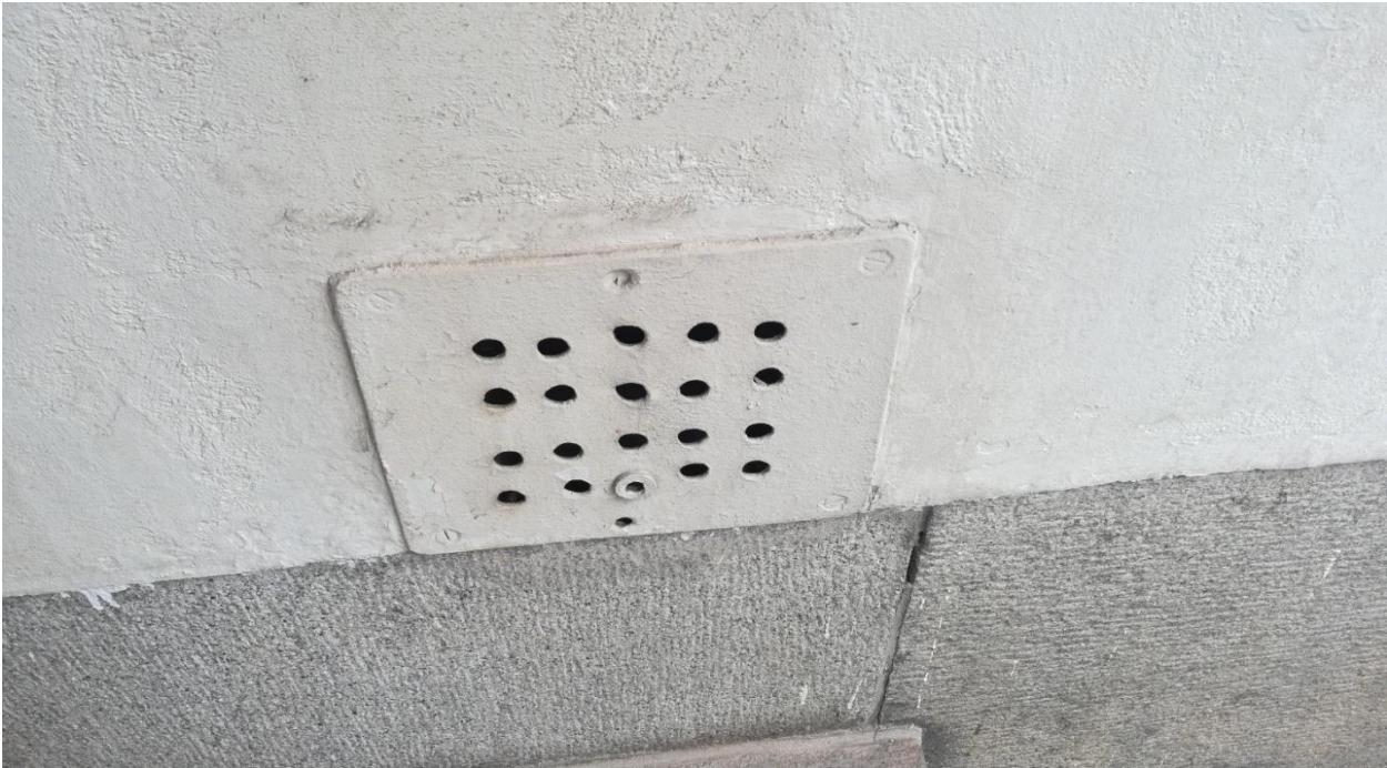
Kuva. Yksityiskohtia julkisivussa, ilmanvaihtorilä sisäänkäyntisyvennyksen sivuseinässä.
