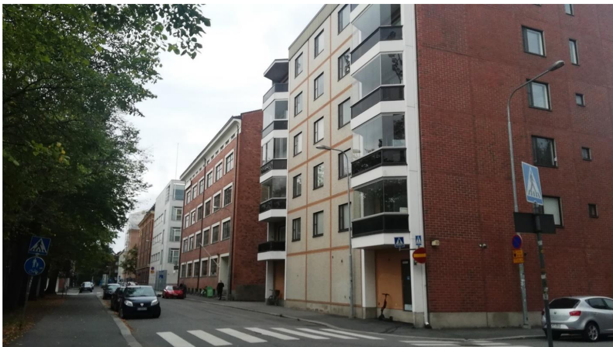
Kuva. Katunäkymä Salhojankadulta etelään. Edustalla 1980-luvulla rakennettu asuinkerrostalo, jonka julkisivut ovat punatiililaattaa ja pesubetonia.
