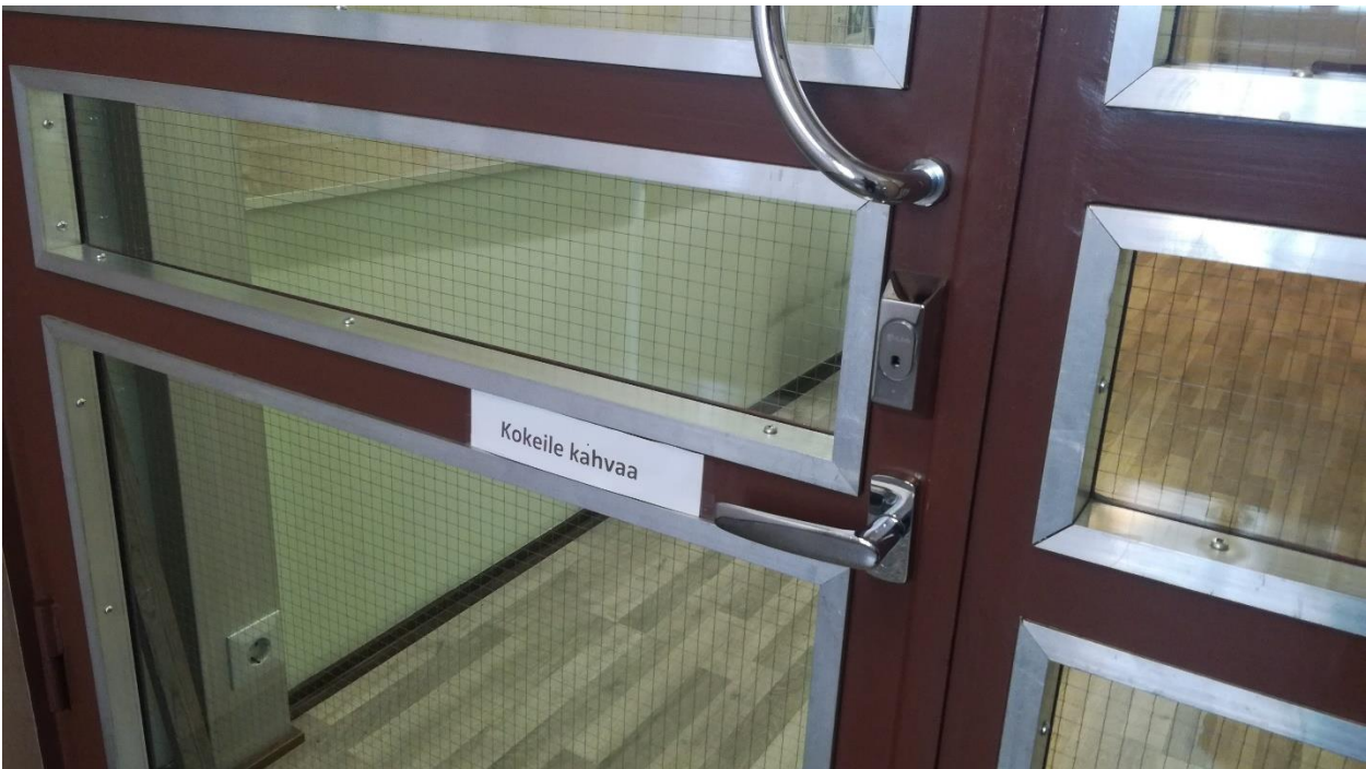
Kuva. Rakennuksen väliovet ovat tyypillisiä 1980-luvun lasimetalliovia, joiden lasiosat ovat rautalankaverkolla vahvistettuja.
