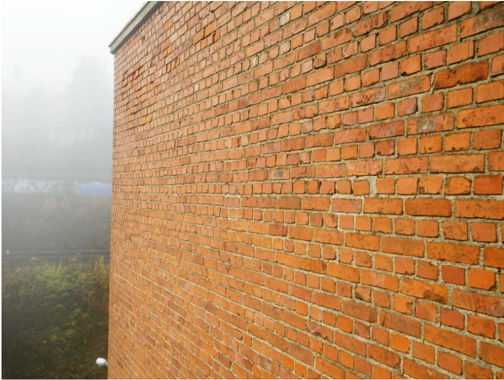
Kuva 11. Itäjulkisivulla julkisivutiilien kunnossa ei havaittu merkittäviä puutteita
