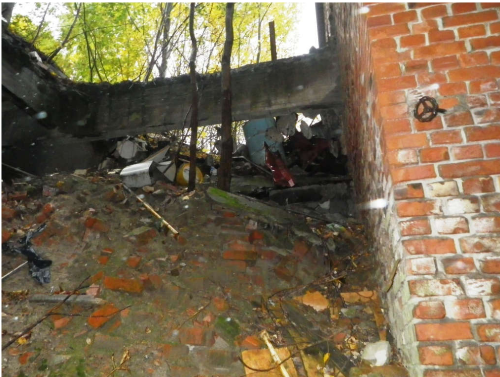
Kuva 12. Pannuhuoneen takana ollut tiilipiippu on purettu. Maanpaineseinän vesieristeitä ei havaittu. Maatäyttö tiilimuurausta vasten.
