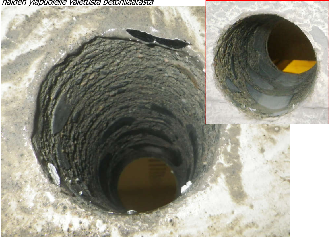
Kuva 14. Lieriöporausta välipohjan primaaripalkista: kiviaineksen raekoko on suuri ja betoni on rapautunutta/huokoista. Pienempien (sekundääri-)palkkien kunto on huono; lieriöporan kiinnittäminen niihin kiila-ankkurilla oli monissa palkeissa epäluotettavaa (rapautumaa)
