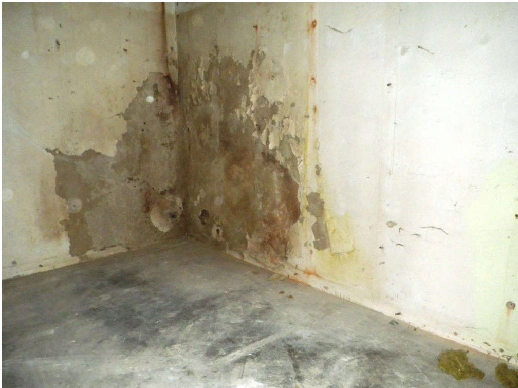
Kuva 26. Kosteusvaurioitunutta maanpainesseinää
