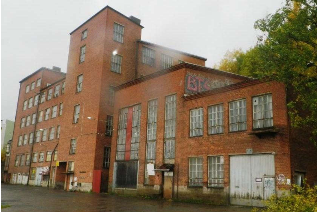
Kuva 1. Yleiskuvaa etelään suuntautuvasta julkisivusta. Oikealla pannuhuone (matalampi)
