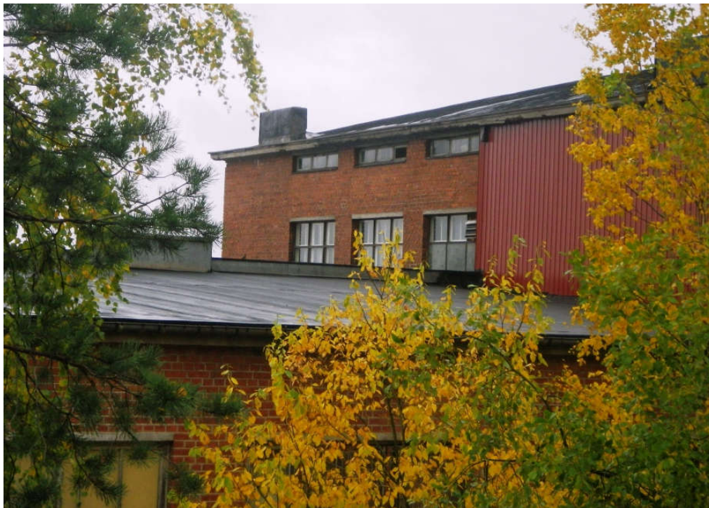
Kuva 16. Pahvitehtaan vesikatteista otettiin haitta-ainenäytteitä: korkeamman osan peltikatteeseen sekä (pulpettikaton takana olevan) peltikatteeseen pinnotteet tutkittiin. Myös etualalla näkyvän pulpettikaton huopakatteeseen PAH-yhdiste tutkittiin. Katon lapeluukun kautta otettiin kaksi näytettä, lämmöneristeen mahdollisen mikrobipitoisuuden selvittämiseksi
