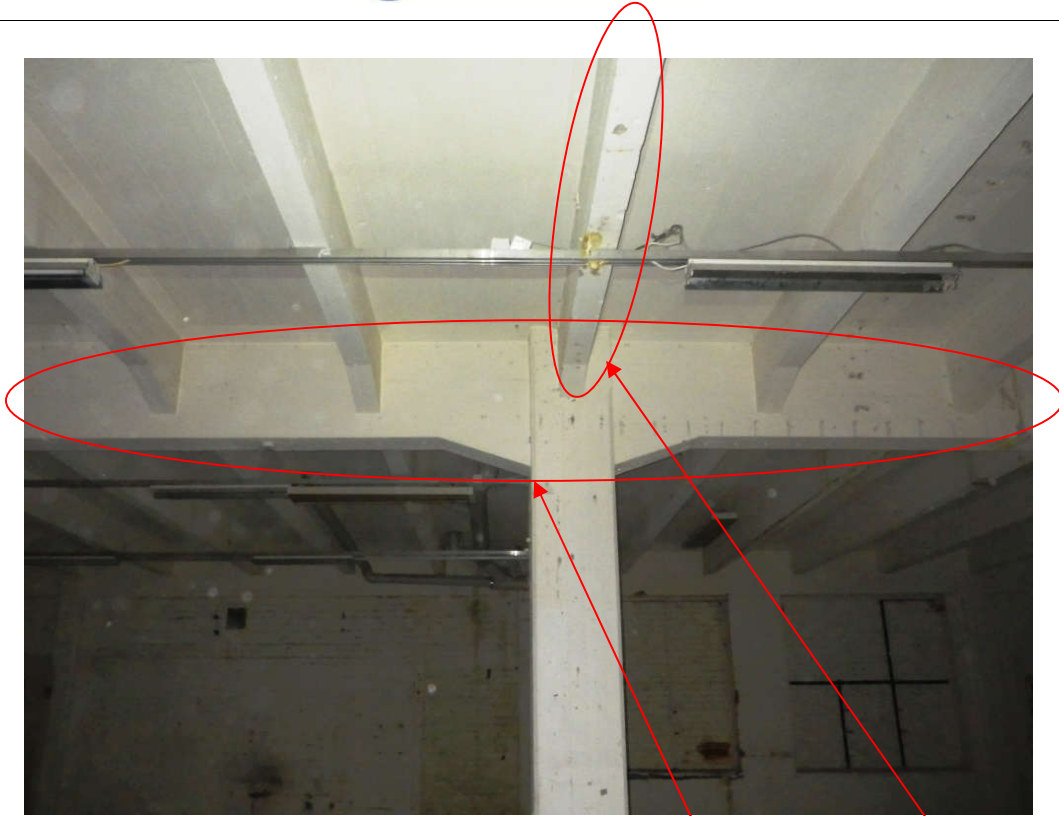
Kuva 13. Puhvitehtaan välipohjat koostuvat primaaripalkeista, sekundääripalkeista sekä näiden yläpuolelle valetusta betonilaatasta
