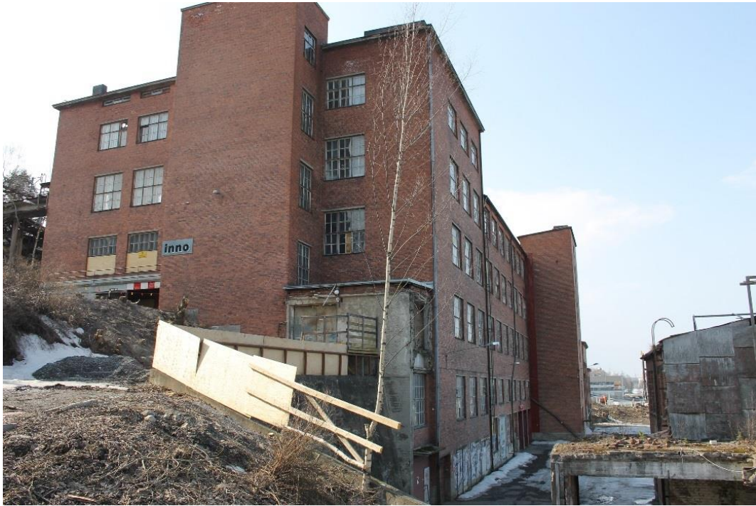
Kuva 3.2 Puhvitehdas kaakosta kuvattuna 15.4.2018
