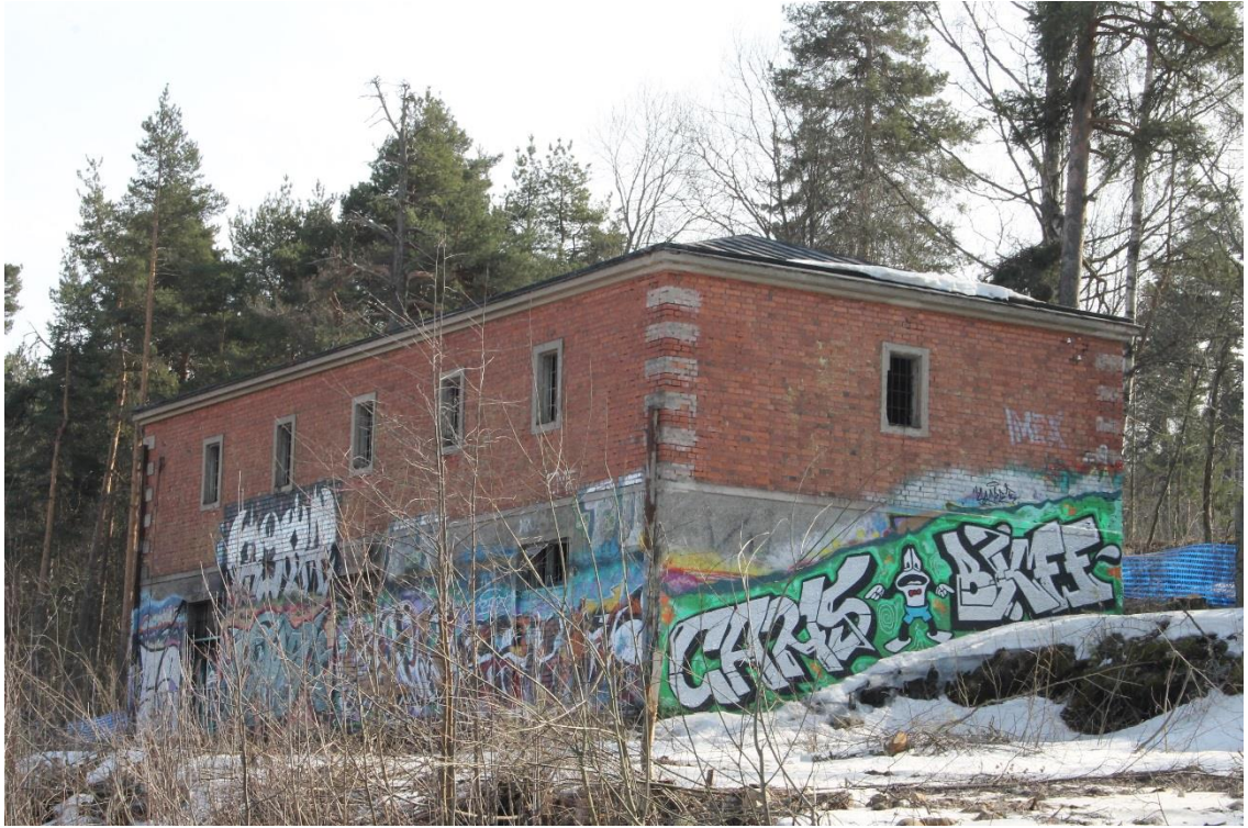
Kuva 5.4 Ruutivarasto luoteesta kuvattuna 15.4.2018
