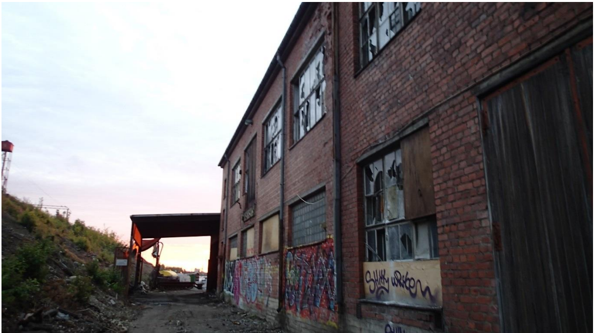
Kuva 10. Pahvitehtaan rakennuksen Pispalan puoleinen sivu
