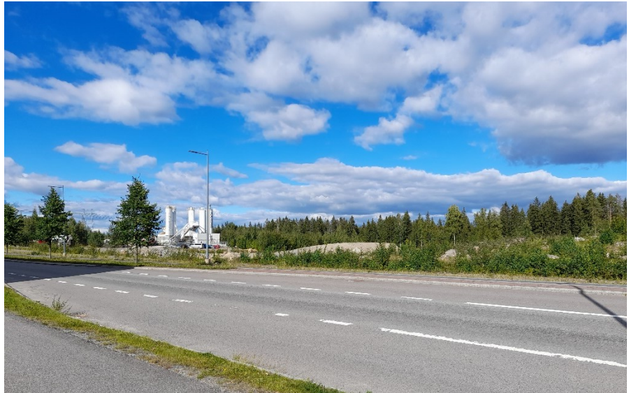
Kuva 1: Alueen keskellä on betoniurakoitsija Swerockin tehdasalue.
