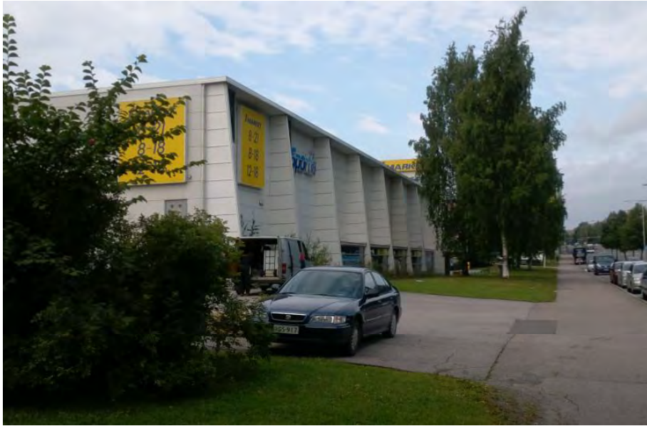
V. 1997 rakennettu liikerakennus, Sammonkatu 60. 8/2013
