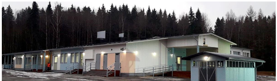
Kuva. Peltolammin koulun uusi väistötila, kuva: Tampereen kaupunki
