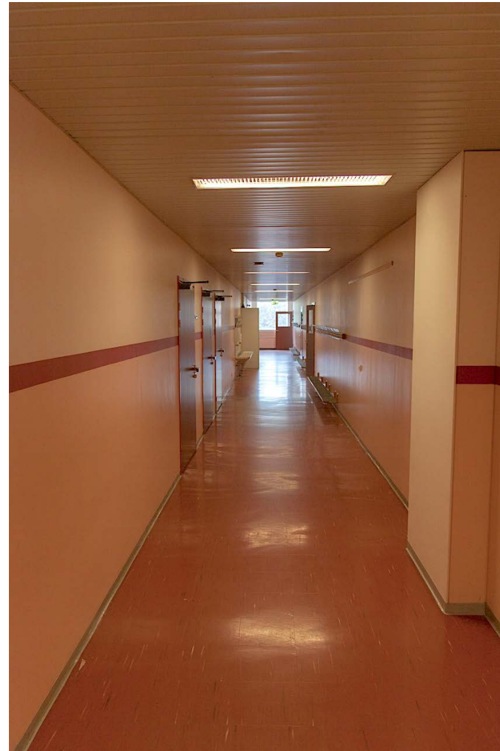
2. kerroksen käytävä, alkuperäiset materiaalit ja rakennusosat.
