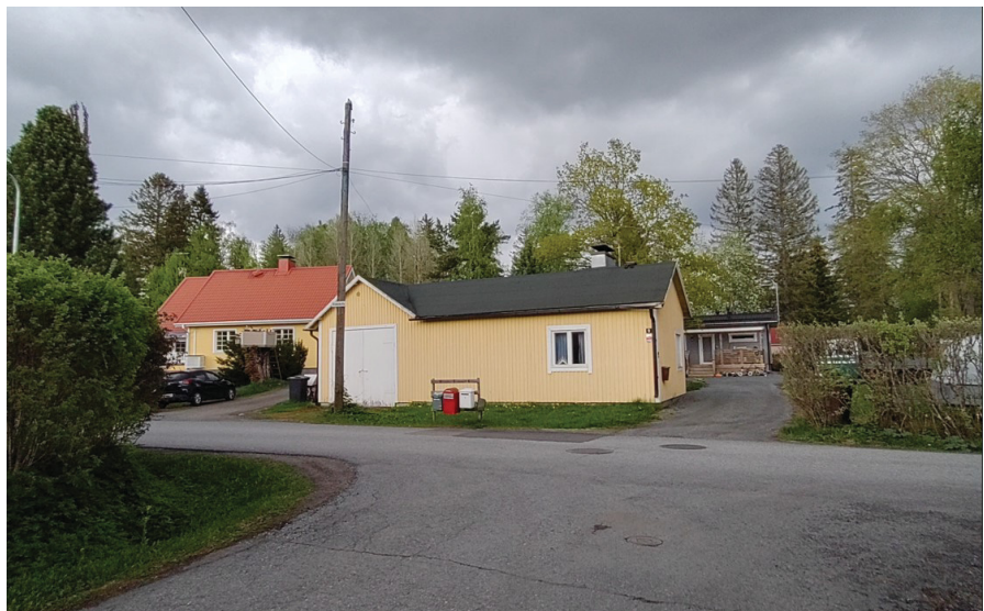
Kuva 2. Valokuva Kytinkadun suunnasta Kiskokadulle. Kuvan keskellä näkyy tontilta purettavaksi aiottu talousrakennus ja sen takaoikealta pilkistää vanhan asuinrakennuksen uudehko lisäsiipi. © Tampereen kaupunki 2022.
