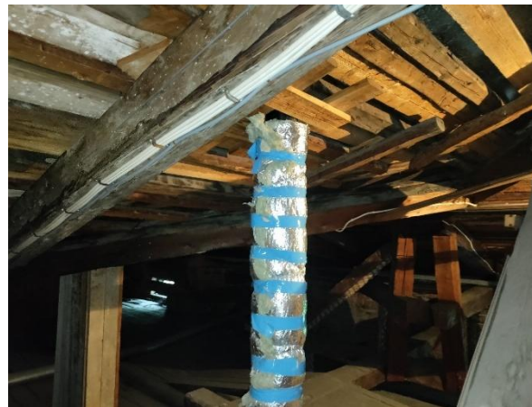
Tuuletusviemäriin eristys ullakolla.
