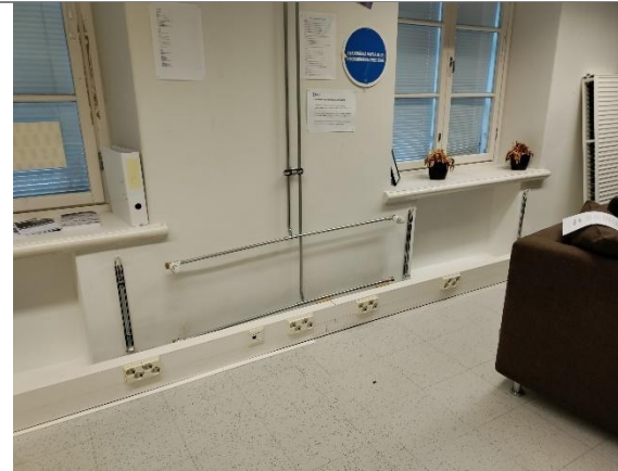
Lämpöpattereita irrotettu kerroksissa.
