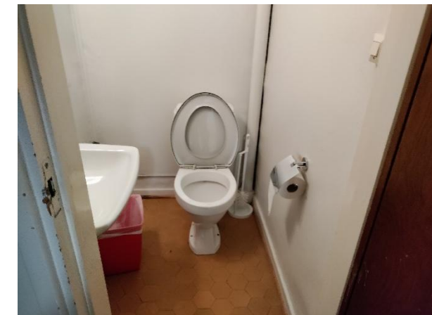
Saneerauskuinoinen WC-tila 3. kerroksessa.
