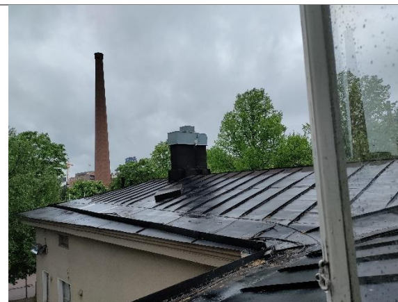
Huippuimuri piipun päässä vesikatolla.
