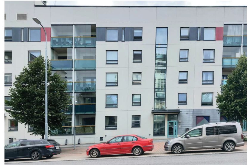
Valkoinen betonielementtijulkisivu sisäänvedetyillä parvekkeilla. Nauha-aihetta ylimmän kerroksen ikkunoissa. Kuva Tampereen kaupunki.
