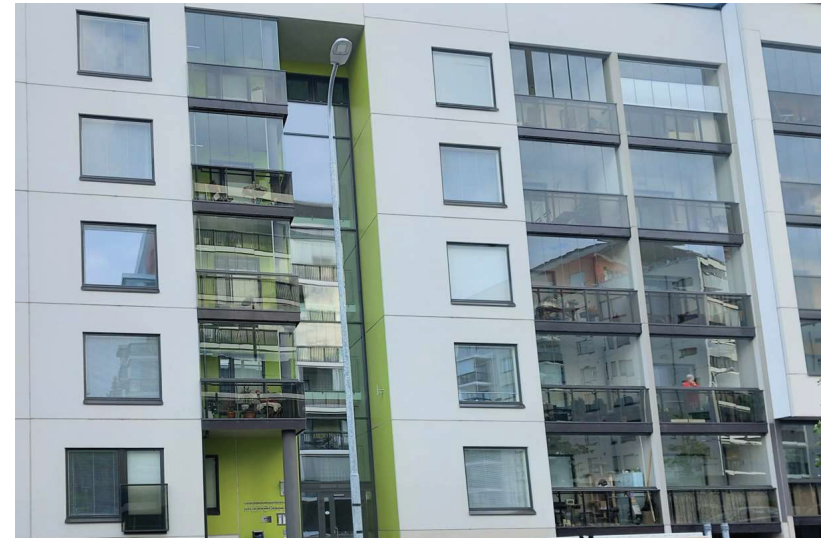
Valkoinen betonielementtijulkisivu, jossa sisäänkäynnit on sijoitettu tehostevärillä korostettuihin syvennyksiin, jossa on myös osa parvekkeista.
