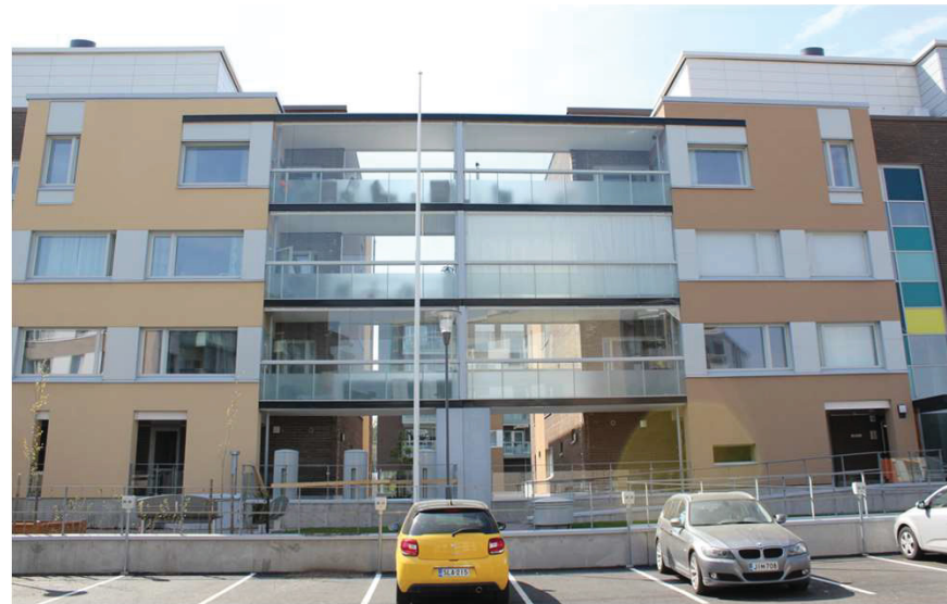
Lamellitalon parvekkeita, jotka kytkevät yhteen erilliset lamellit. Kuva Tampereen kaupunki.
