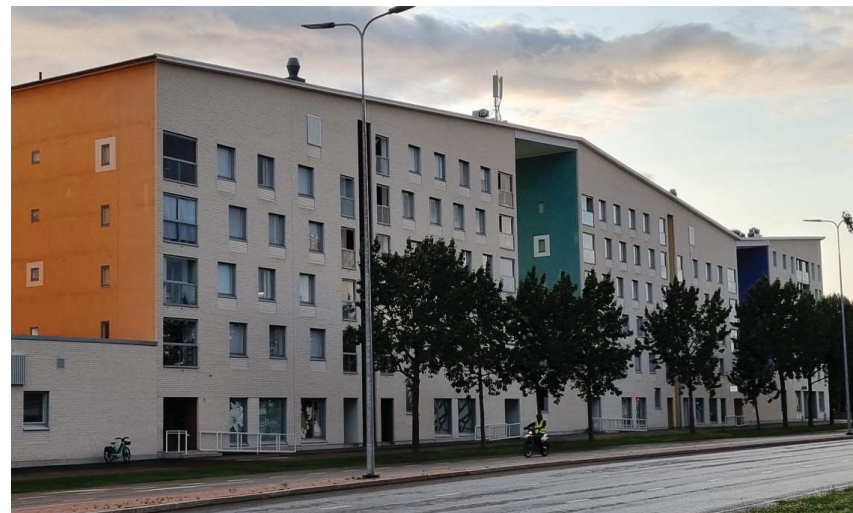
Melusuojauksen muodostava lamellitalo, jossa parvekkeet ovat sisäänvedettyjä tai ranskalaisia parvekkeita. Kuva: Tampereen kaupunki.
