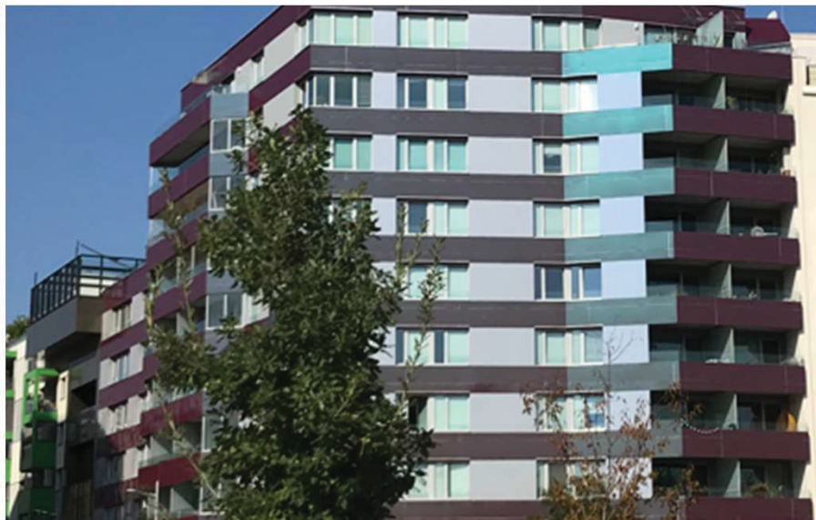
Ikkunoita ja osittain parvekkeitakin levy materiaalin avulla nauhoiksi koottuina Helsingin Kalasatamassa. Kuva Tampereen kaupunki.
