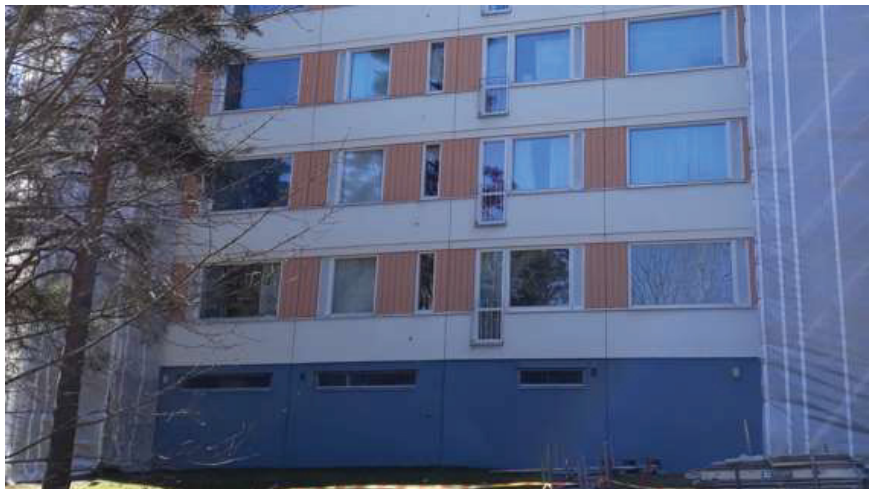
Kuva 18: Ruotulan torneissa olivat ennen korjausta näkyvissä mm. Aarne Heinolle tyypilliset ikkunavälien pystyuritus ja ranskalaisten parvekkeiden sirot pinnakaiteet. kuva Tampereen kaupunki.
