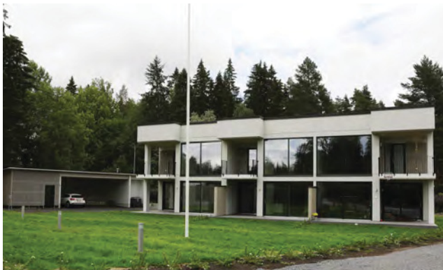
Kuva 49. As Oy Ruotujaakon julkisivu länteen.
