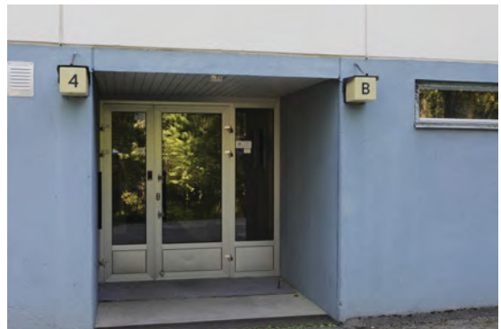
Kuva 31. Sisäänkäyntisyvennys ja uusittu ulko-ovi tornissa 2 (4B).
