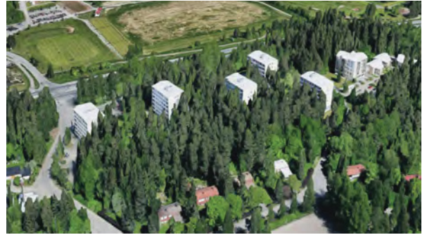
Kuva 54. Ilmakuva Ruotulan torneista. (Google Maps)
