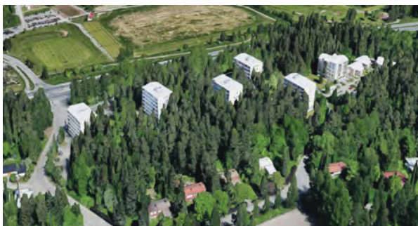
Kuva 71. Ilmakuva Ruotulan torneista. (Google Maps)
