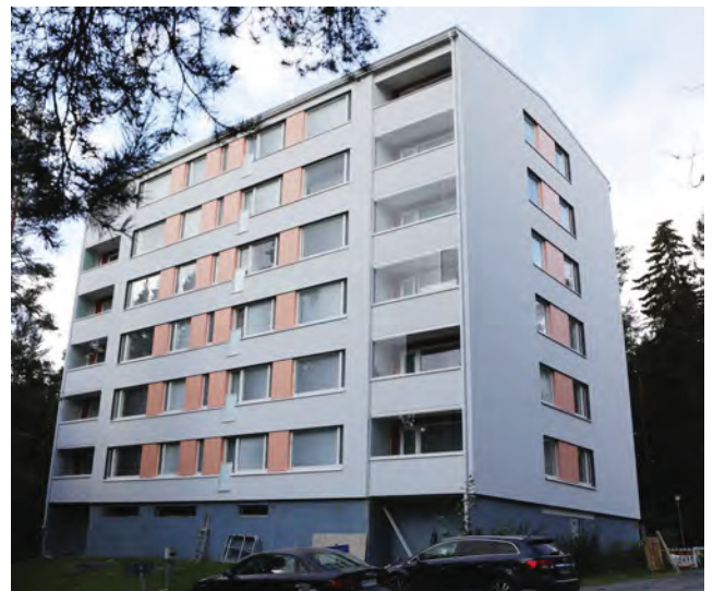
Kuva 69. Tornin 5 (10E) lähes valmis julkisivukorjaus vuonna 2021. Sokkelista puuttuu uusi hammaa laatoitus.
