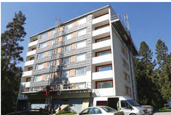
Kuva 35. Torni 5 (10E) lännestä kuvattuna 2021. Julkisivuremontti on käynnissä.
