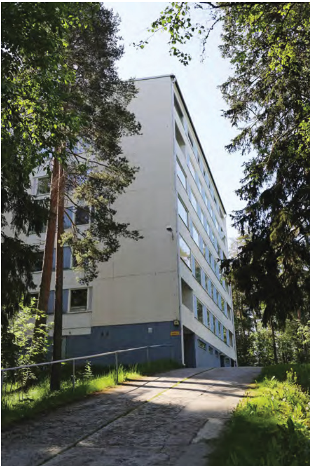
Kuva 28. Torni 2 (4B) pohjoisesta kuvattuna 2021.
