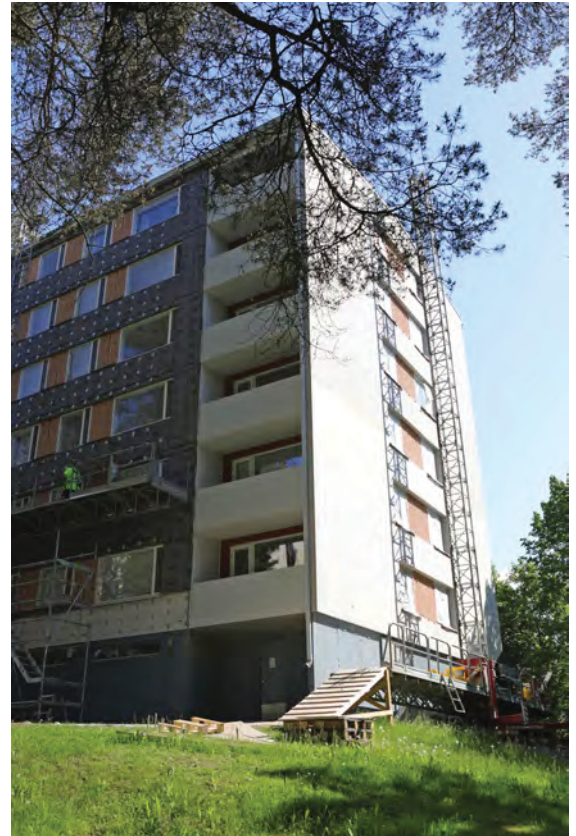
Kuva 61. Tornin 5 (10E) julkisivun korjaustyö on käynnissä.
