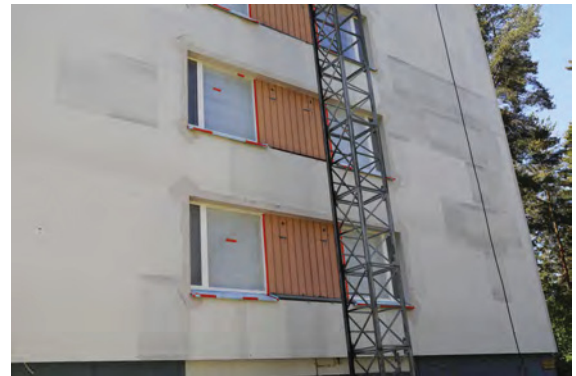
Kuva 62. Tornin 5 (10E) julkisivun päätyä.
