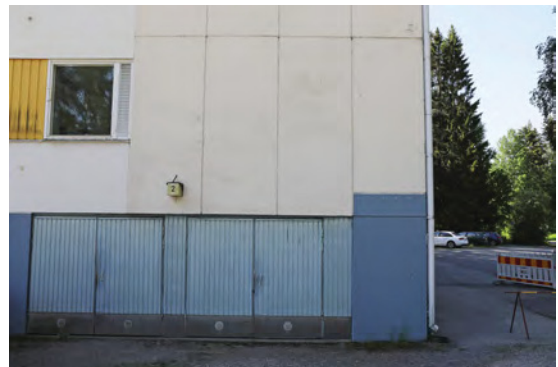
Kuva 30. Autotallin ovet ja pykällys sokkelissa tornissa 1 (2A).
