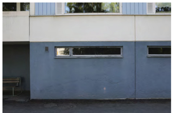
Kuva 32. Maantasokerroksen leveä ikkuna tornissa 2 (4B).
