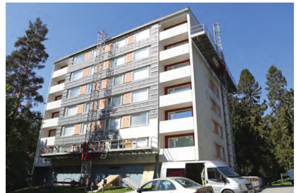
Kuva 63. Tornin 5 (10E) julkisivua korjaustyön aikana idästä.
