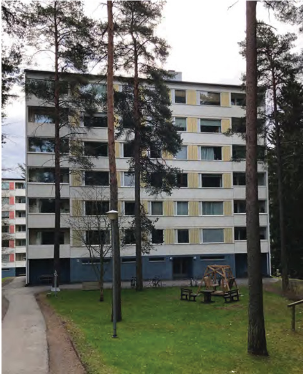
Kuva 33. Torni 3 (6C) lännestä kuvattuna 2020.
