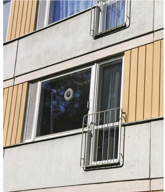
Kuva 36. Ranskalaisen parvekkeen pinnakaiteet tornissa 1 (2A).
