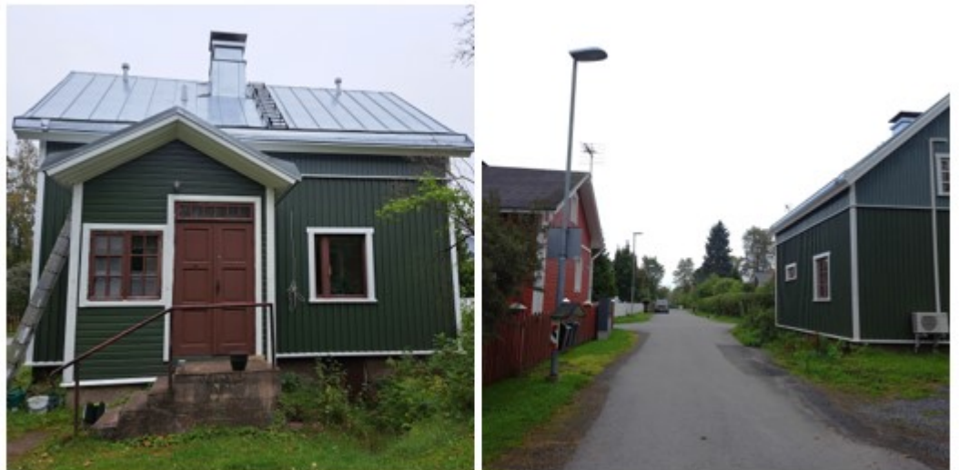
Kuva 2. Vasemmalla julkisivu pihan puolelta. Oikealla näkymä Kaarilahdenkujan suunnasta. Kuvat: Tampereen kaupunki, asemakaavoitus 2023
