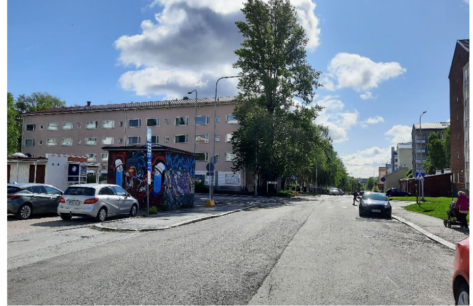
Vanhan Domuksen A-talo Väinämöisenkadulla kohti itää katsottaessa. Kuva Tampereen kaupunki 2023.
