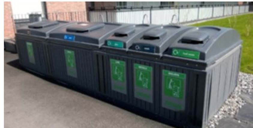
Syväkeräyssäiliöiden avulla voidaan minimoida jätehuollon tilantarve. Eri toimintoja voidaan rajata esim. pensaiden avulla visuaalisesti toisistaan. Kuva Tampereen kaupunki 2020.
