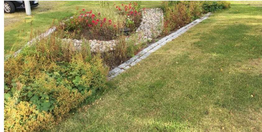
Esimerkkikuva hulevesien viivytyrakenteesta. Kuva Tampereen kaupunki 2021.
