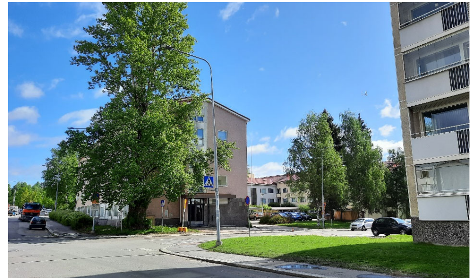
Vanhan Domuksen A-talo Joukahaisenkadulla kohti pohjoista katsottaessa. Kuvassa näkyvä puu on poistunut kuvan ottamisen jälkeen. Kuva Tampereen kaupunki 2023.
