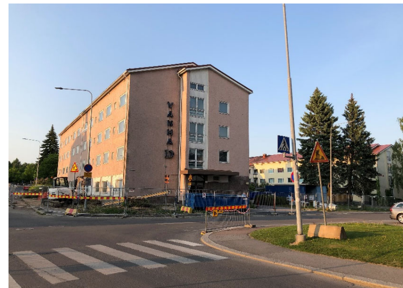
Vanha Domus kesällä 2023 A-rakennuksen peruskorjauksen alettua. Kuva Tampereen kaupunki 2023.
