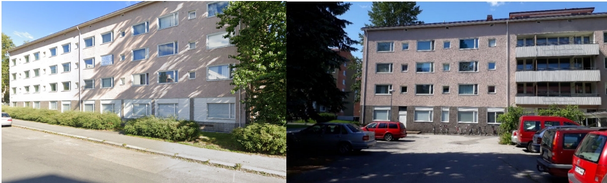
A-talon julkisivuja itään ja länteen vuonna 2021.
