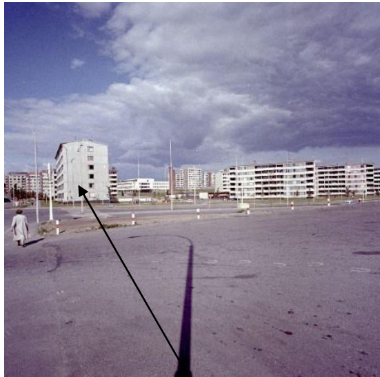
As Oy Lemminkäisenk.2 oli 1961 Suomen ensimmäinen täyselementti-rakennus, ruutuelementeistä koottu asuin kerrostalo. 17 Kuva: Kalevan kerros-taloja, E.M. Staf, TM. Uusi Domus sijoittuu arkkitehtonisena esimerkkinä luontevasti rationalistisemmän Taka-Kalevan rakennuskantaan.
