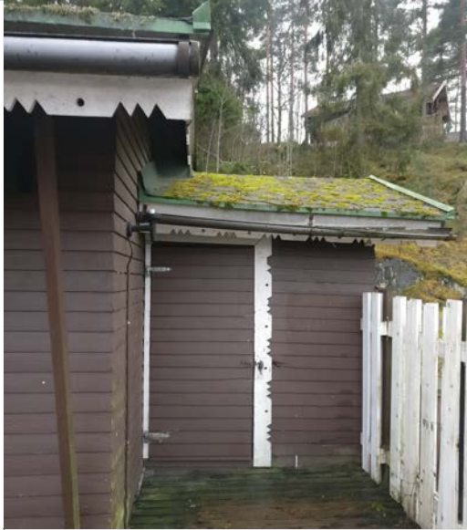
Puuvaja rakennuksen päädyssä
