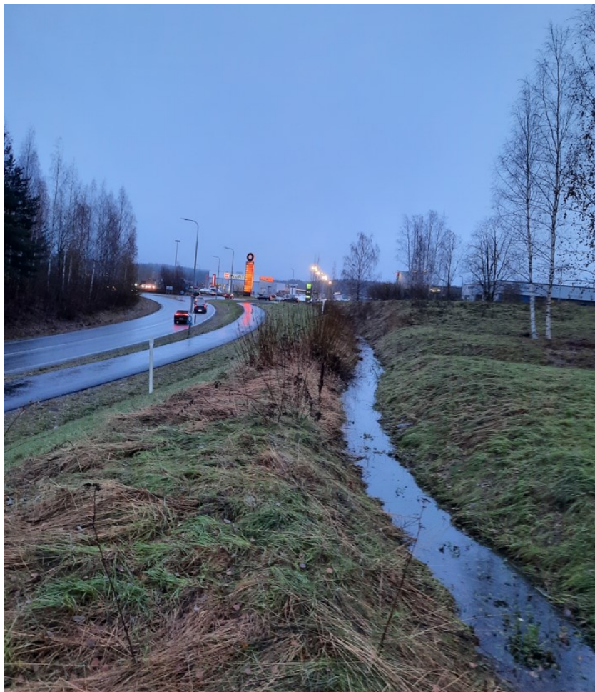
Kuva 4. Väylän länsipenkereen päällä avo-ojan hulevesi laskee etelään kohti Toivionkatua. Kuva on otettu Tampereen ja Pirkkalan rajalta kohti etelää. © Tampereen kaupunki 2023.
