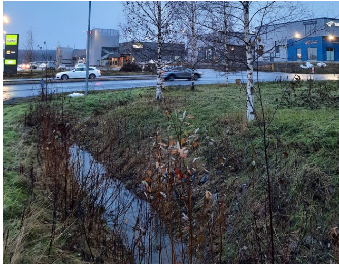
Kuva 5. Penkereeltä avo-ojan hulevedet kulkevat Toivionkadun alittavaan rumpuun. Kuvan avo-oja ja koivuistutukset kuuluvat vireillä olevan asemakaavan rajaukseen.
