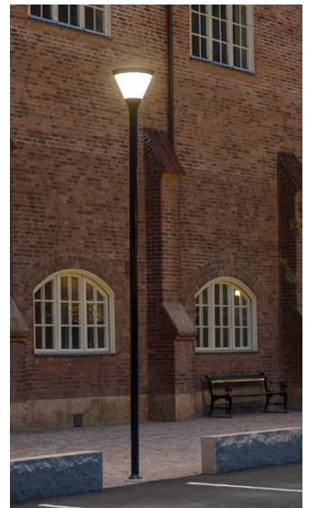
Aukiotilan valaisinesimerkki Focus Lighting Skypark
