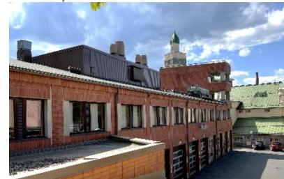
Keskuspaloaseman laajennus, Sirkku Laine 10.06.2021.
