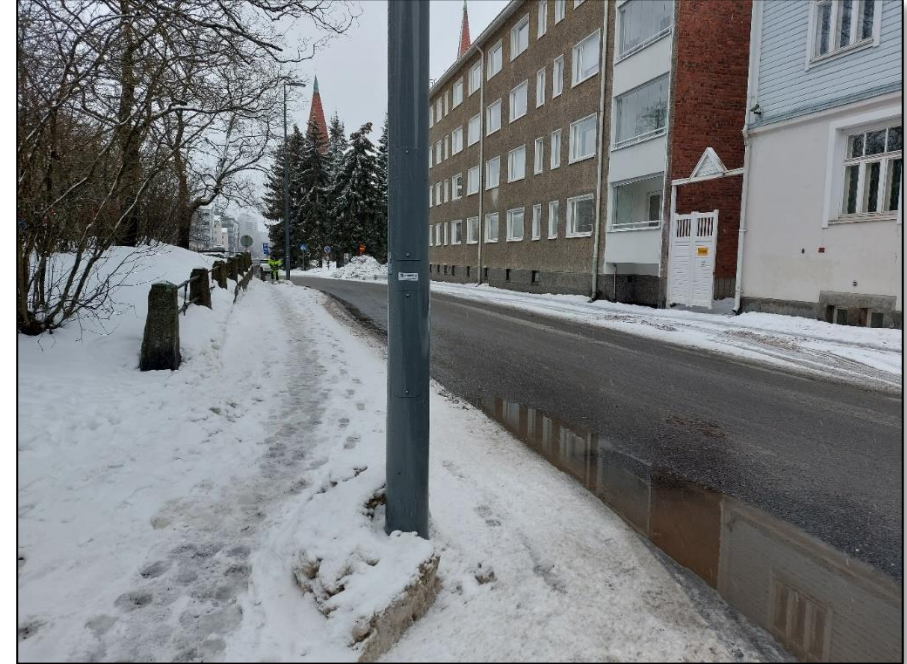
Kuva 5. Reunakiven viereen sijoitettu valaisinpylväs hankaloittaa kapean jalkakäytävän talvikunnossapitoa. (kuva: P. Liukkonen, WSP)
