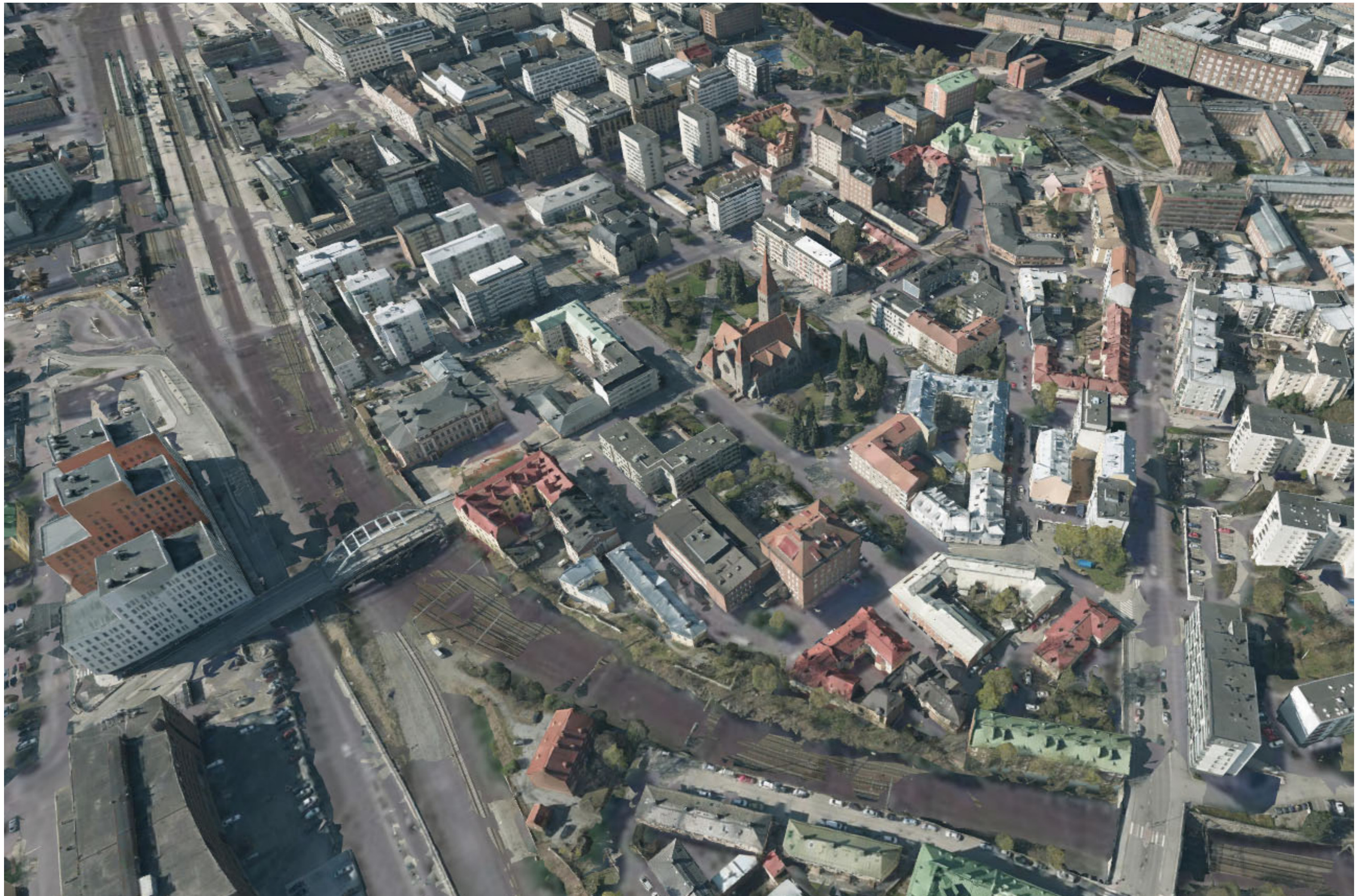
Alueen nykytila, näkymä koillisesta ( tampere.kunta3d.fi)
