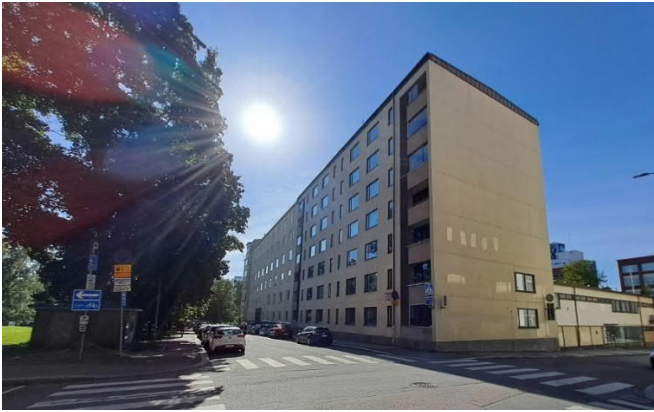
Kuva 9. Näkymä Aaltosenkadun ja Lähteenkadun kulmasta suunnittelualueelle, edessä As Oy Akopuiston kerrostalo. Vasemmalla on Sorsapuiston kulmausta. Oikealla näkyy Lähteenkadun purettava kaksikerroksinen rakennusosa. Kuva: Sanna Lahti 2023.
