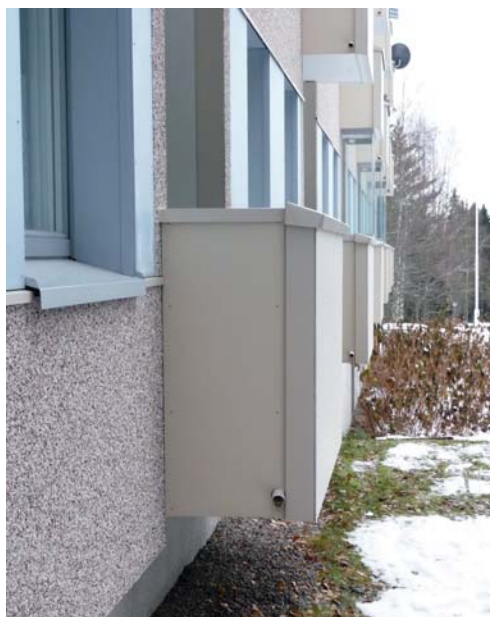
Ylimmässä kuvassa alkuperäinen julkisivu, joka on maalattu. Keskellä ja alla kuvassa lisälämmöneristetty ja levytetty talo.
