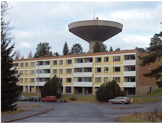
Peltolammin vesitorni erottuu selkeästi Multisillan Kitiniitynkadulle.
