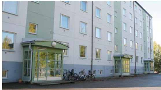
Porrashuoneiden sisäänkäynteihin on tehty laajennuksia.
