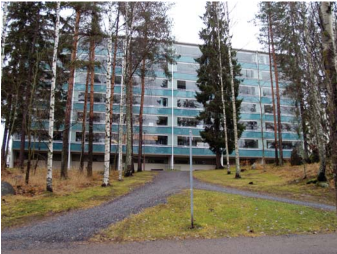
Uusittuja parvekkeita Lentävänniemenkadulla sijaitsevilla taloilla.
