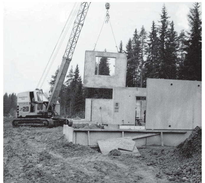
Ruotulan omakotitalot olivat maan ensimmäiset täselementtirakenteiset pientalot. Parhaimmillaan yhden talon seinäelementit asennettiin viidessä tunnissa. (lähde: Aarre Mattisen valokuvakoelma / Rakennusliike Mattinen & Niemelä Oy)
