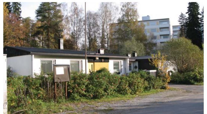
Ruotulan kerrostaloaluetta Tornimäenkäldulta ja pientaloaluetta Pokalankadulta. As Oy Ruotulan Tornit muodostaa yhtenäisen kokonaisuuden, jossa myös rakennusten alkuperäinen, taloittain vaihteleva väriero on onnistuttu säilyttämään.
