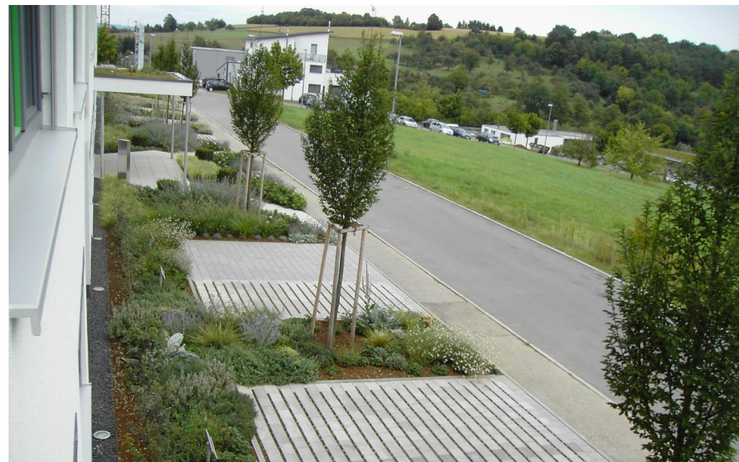
Kuva 12. Avosaumattua, läpäisevää kiveystä pysäköintiruuduissa ja biosuodatusta niiden välissä työpaikka-alueella Eslingenissä Saksassa. Kuva Sitowise Oy.
