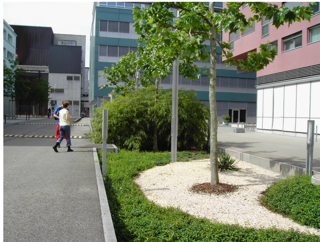
Kuva 10. Reunakivellä alas laskettu biosuodatusrakenne Zürich Westin yritysalueella. Kuva Ismo Häkkinen
