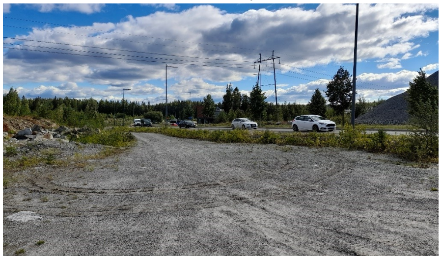
Kuva 2: Alueen halki kulkee 110 kV:n voimajohto.
