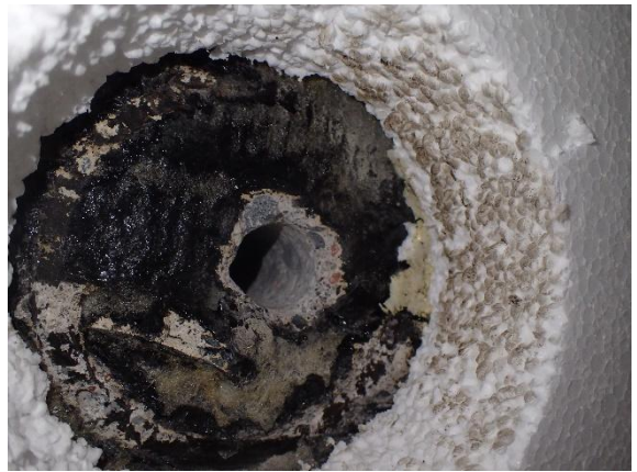
Kuva 6 Varaston K03 korjatun maanvastaisen seinän betonirakenteessa bitumisively.
