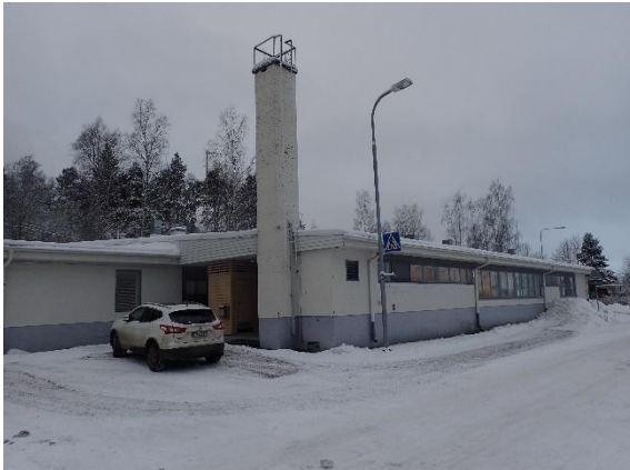
Kuva 19 Yleiskuva rakennuksesta. Maanpinta on osin melko alhaalla
