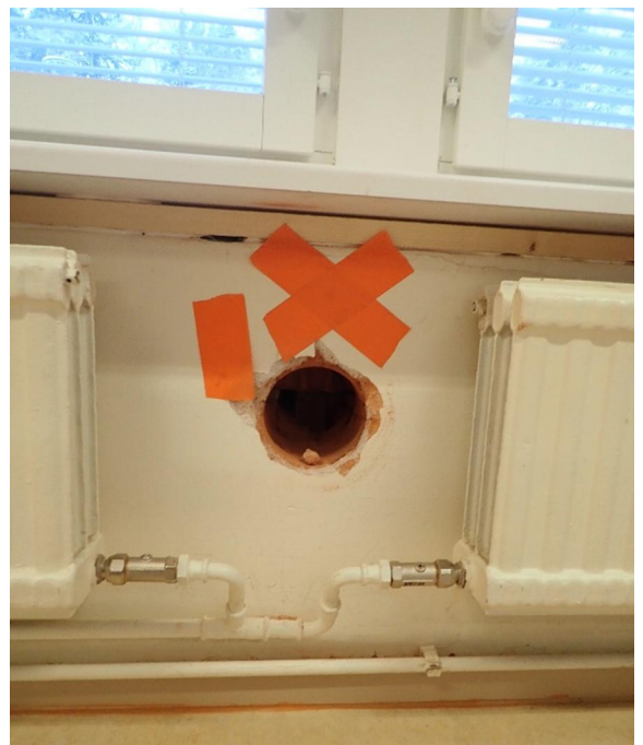
Kuva 4 Rakenneavauksen kautta todettiin, että ulkoseinärakenne on lähtötietojen mukainen.
