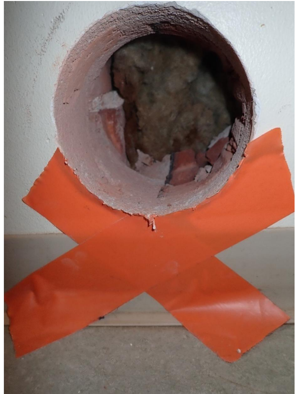
Kuva 14 Rakenneavauksen kautta todettiin, että väliseinänä on alkuperäinen ulkoseinärakenne.
