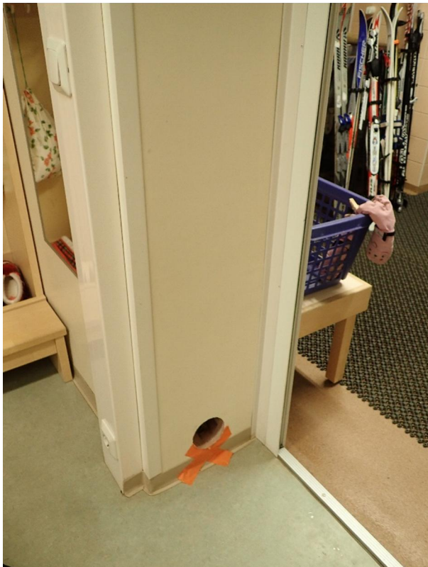
Kuva 13 Rakenneavauksen sijainti eteisessä 137.
