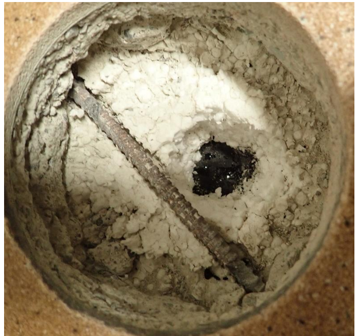
Kuva 18 Havaintojen mukaan välipohjaa on korjattu, sillä alkuperäistä sementtilastuvillalevyä ei rakenteessa todettu.
