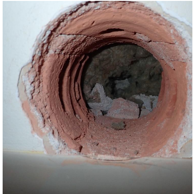
Kuva 10 Rakenneavauksen kautta todettiin, että väliseinänä on alkuperäinen ulkoseinärakenne.
