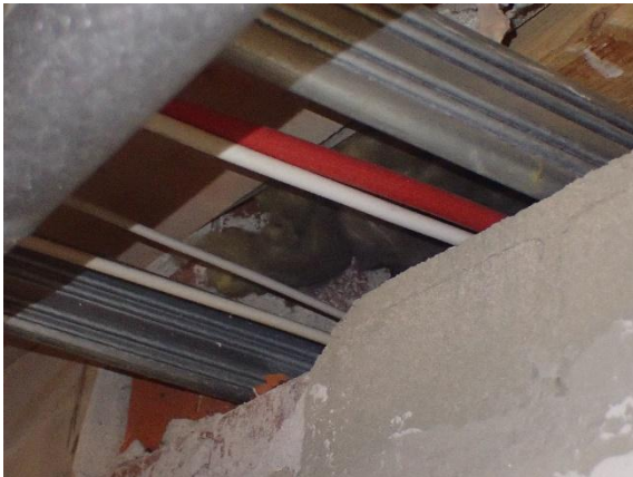
Kuva 31 Yläpohjan paljaita eristeitä tilojen 122 ja 124 väliseinän kohdalla.
