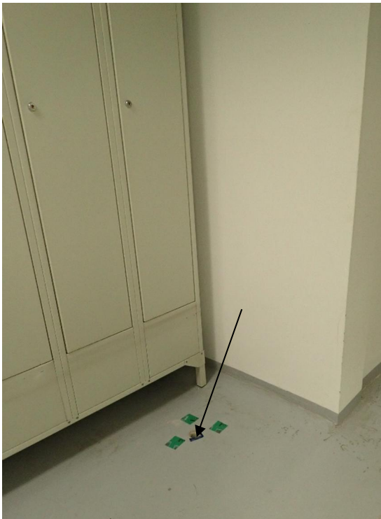
Kuva 21 Rakenneavauksen sijainti pukuhuoneessa K06.
