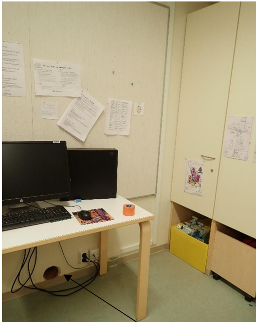
Kuva 9 Rakenneavauksen sijainti ruokailu-/askartelutilassa 125
