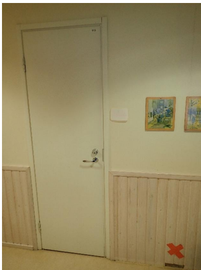
Kuva 15 Rakenneavauksen sijainti käytävällä 112.
