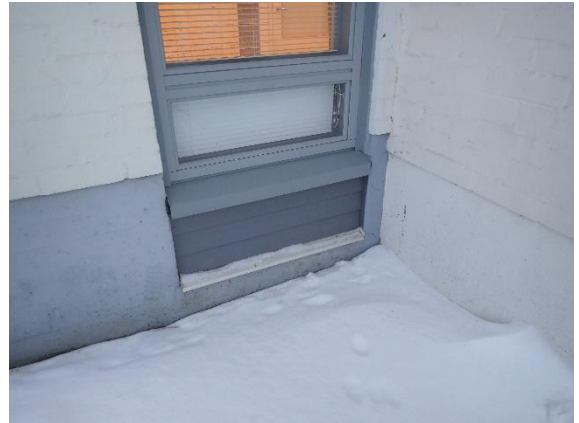
Kuva 20 Vesileikkihuoneen 121 kohdalla vanhaan ovi-aukkoon on asennettu ikkuna.
