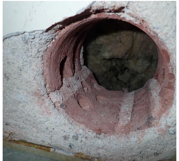
Kuva 12 Rakenneavauksen kautta todettiin, että väliseinänä on alkuperäinen ulkoseinärakenne.
