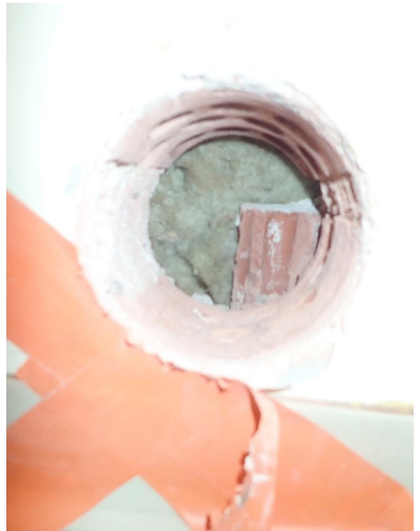
Kuva 6 Rakenneavauksen kautta todettiin, että ulkoseinä-rakenne on lähtötietojen mukainen.
