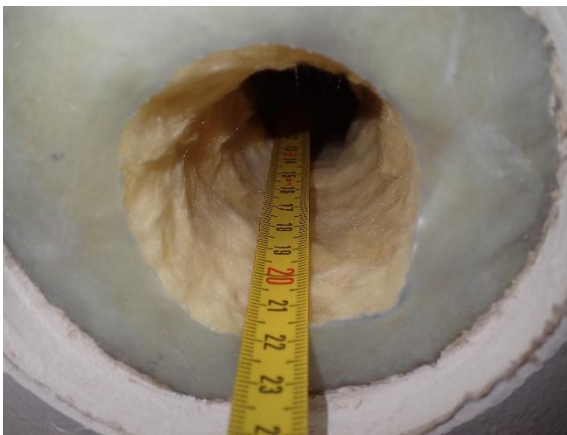
Kuva 1 Rakenneavaus käytävällä 122 (ulkoseinä). Rakenne vastaa suunnitelmia.
