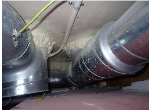
Kuva 30 Yläpohjan läpivientien tiivistyskorjauksia on tehty uretaanivaahdolla.
