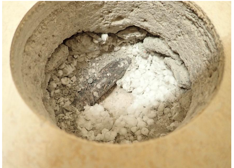
Kuva 20 Havaintojen mukaan välipohjaa on korjattu, sillä alkuperäistä sementtilastuvillalevyä ei rakenteessa todettu.
