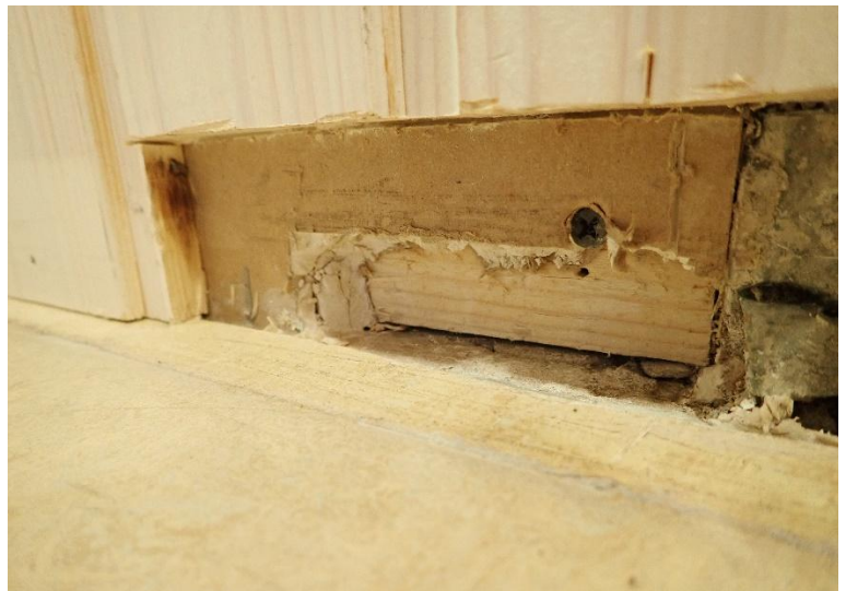
Kuva 16 Puurakenteinen ja betonirakenteinen seinä ovat vasten alapohjalaattaa.
