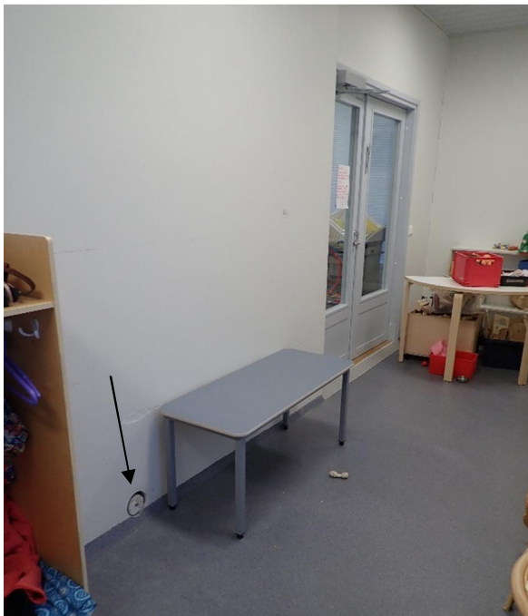
Kuva 7 Rakenneavauksen sijainti käytävällä/pienryhmätilassa 122.
