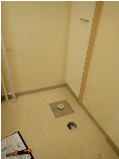
Kuva 19 Rakenneavauksen sijainti pienryhmätilassa 111
