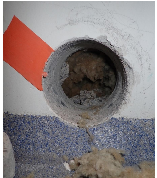
Kuva 8 Rakenneavauksen kautta todettiin, että väliseinänä on alkuperäinen ulkoseinärakenne.
