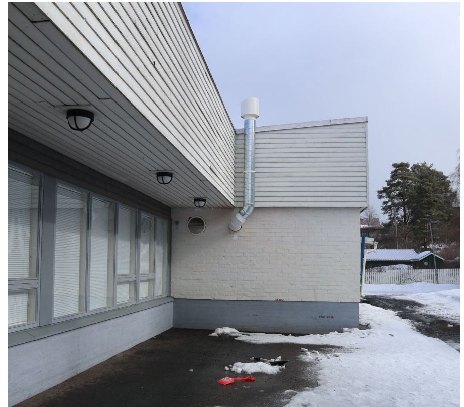
Koivistonkylän päiväkodin eteläistä julkisivua.
