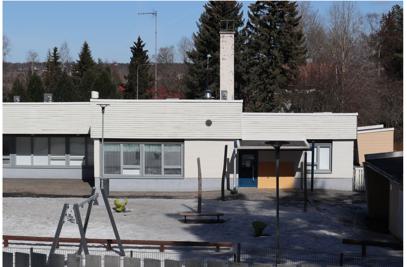
1980-luvulla rakennettu seinä erottuu keltaisina laattoina julkisivussa.
