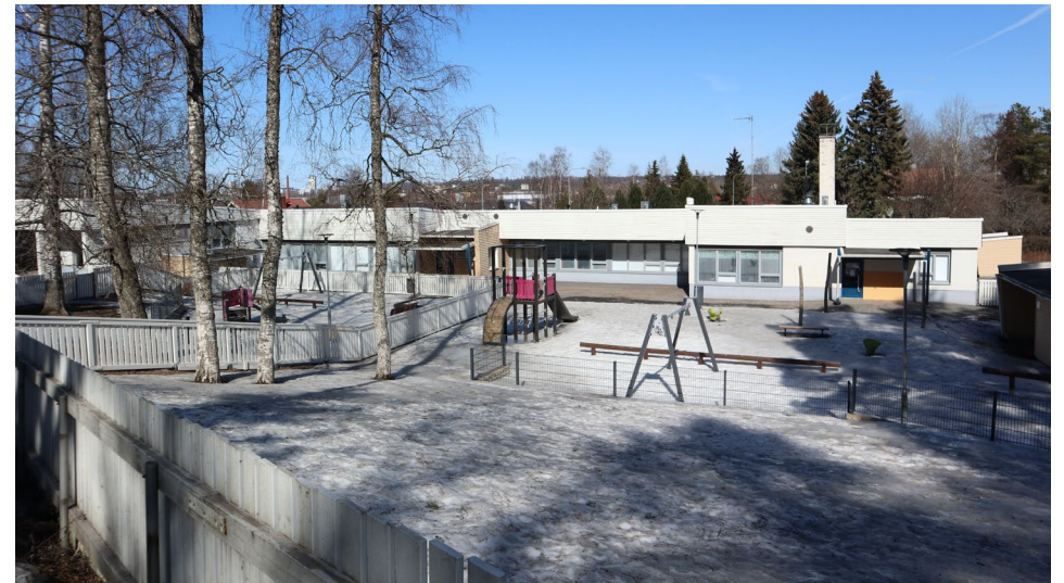
Päiväkodin piha-aluetta ja eteläjulkisivua, taustalla Tampereen keskustan siluettia.
