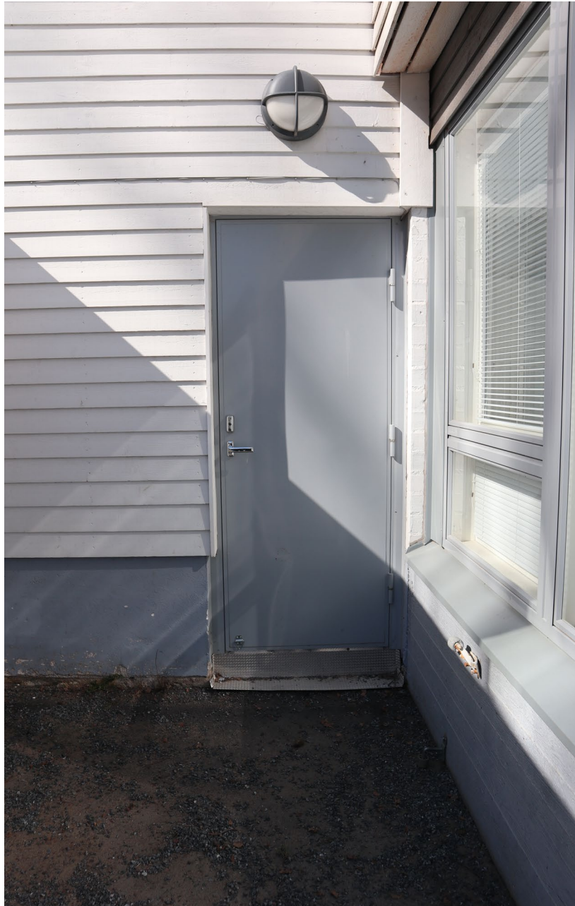
Neuvolarakennuksen ja päiväkodin yhdistävä vuonna 2015 rakennettu laajennusosa, ovi eteläiselle sisäpihalle.
