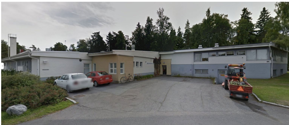
Päiväkodin pohjoisjulkisivun ilme vuoden 2005 saneerauksen jälkeen. Alkuperäinen kuva: Google maps elokuussa 2011.
