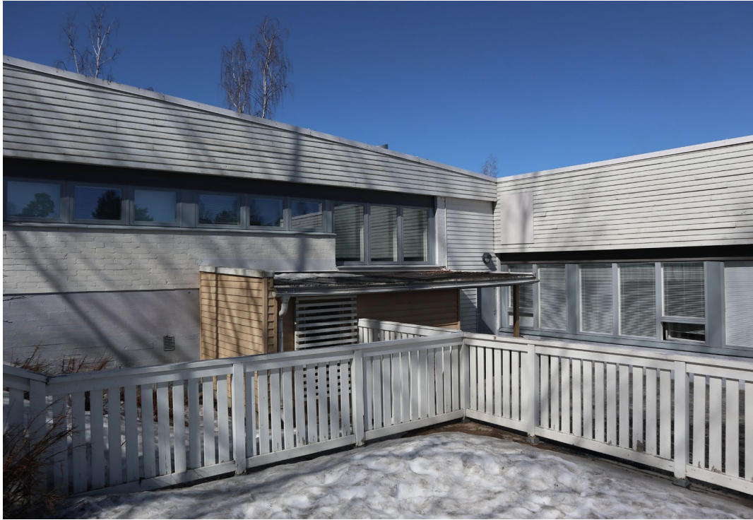
Etelä- ja itäjulkisivua, vuonna 2005 rakennettu keltainen ulkovarasto keskellä.
