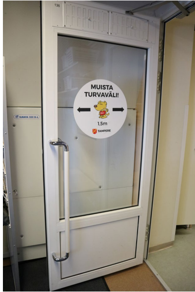
Itäisen sisäänkäynnin eteisen väliovi.
