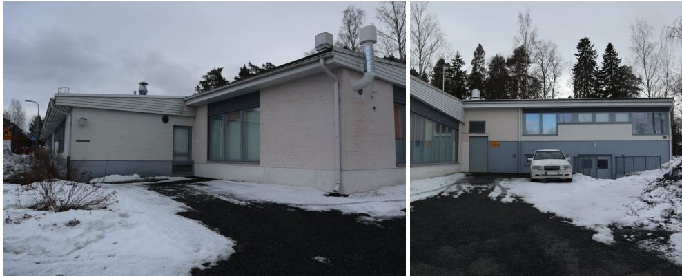
Valokuvat pohjoisjulkisivusta maaliskuussa 2022.
