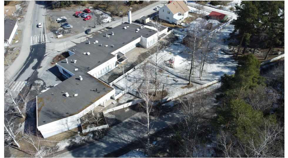
Ilmakuva päiväkodista ja piha-alueesta kohti pohjoista.
