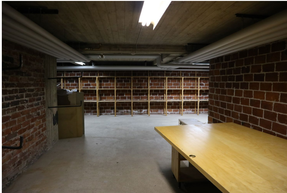
Isompi varastotila, joka alkuperäisessä pohjapiirroksessa merkitty kaivamattomaksi tilaksi. Varastotila on kaivettu ja otettu lattian perusteella käyttöön myöhemmin, tarkemmasta ajankohdasta ei tietoa.
