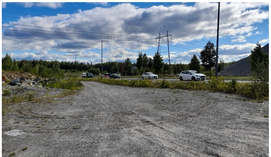
Kuva 2: Alueen halki kulkee 110 kV:n voimajohto.
