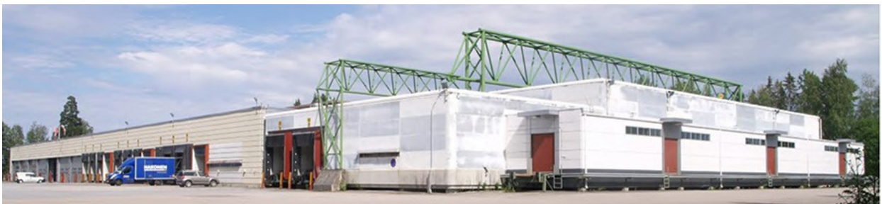
Kuva. Näkymä Valion rakennuksesta etelästä (valokuva arkkitehdit MY)
