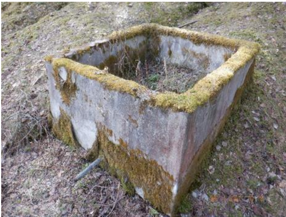
Kuva 5. Vähäsilta, kohde 2, Betonirakenne, jossa juoksutusputki. Kuvattu luoteeseen.
