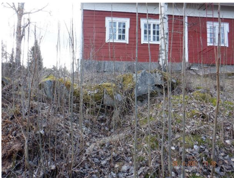
Kuva 9. Vähäsilta, kohde 6. Päätalon pohjoisen puoleisella rinteellä oli romahtanut kellari. Kuvattu etelään.
