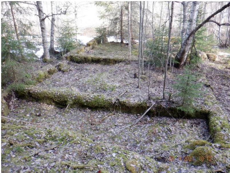
Kuva 7. Vähäsilta, kohde 4. Rakennuksen kivijalka. Kuvattu pohjoiseen.
