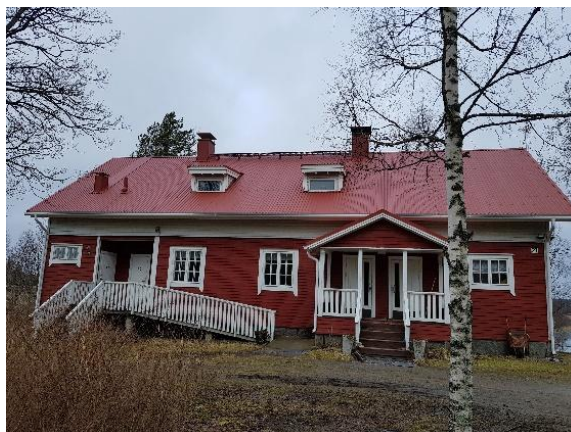
Kuva 1. Vähäsillan leirikeskuksen päärakennus.
