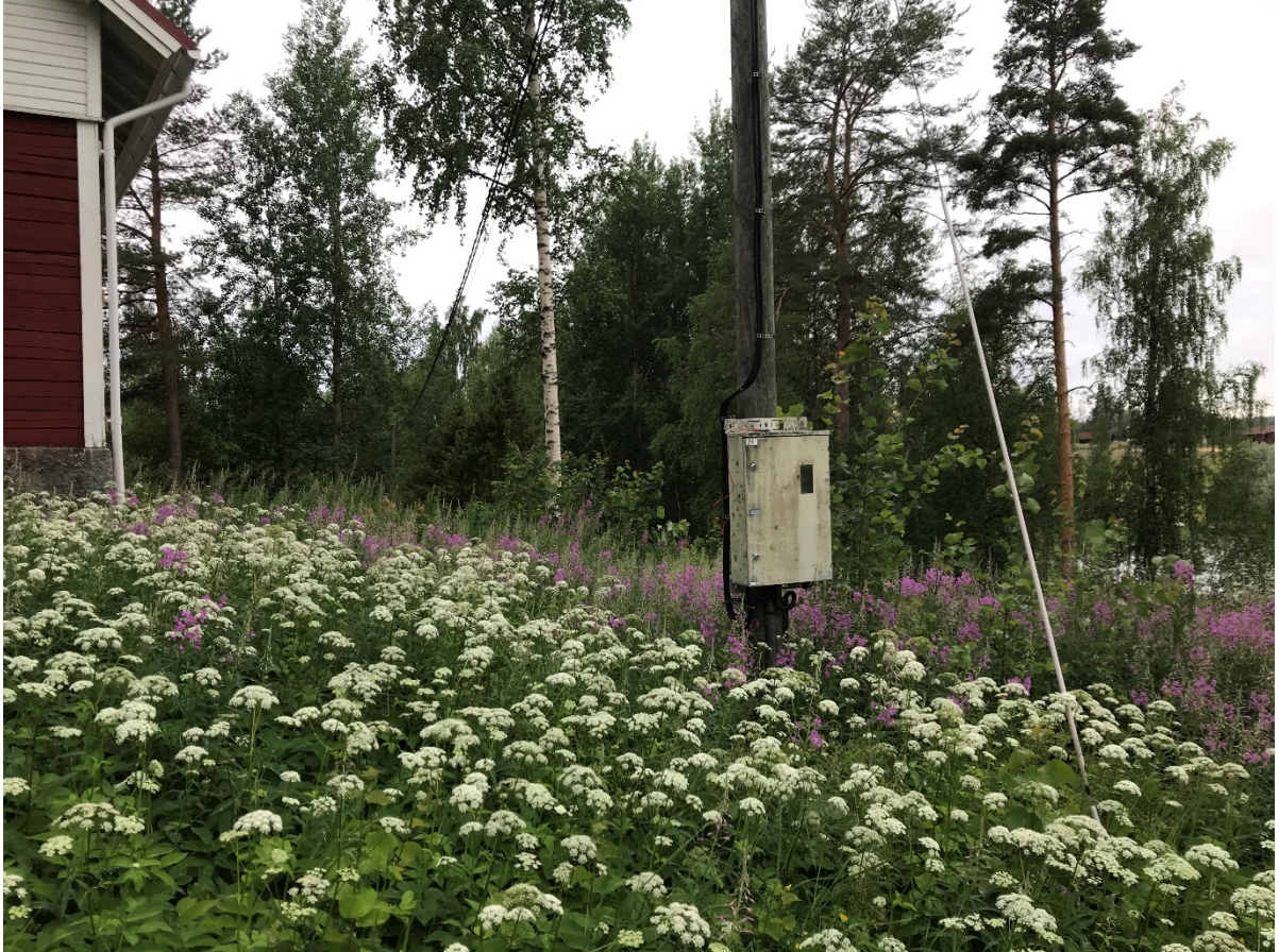
Kuva 3-6. Valokuva kuviosta 2, Vähäsillan päärakennuksen länsipuolelta.
