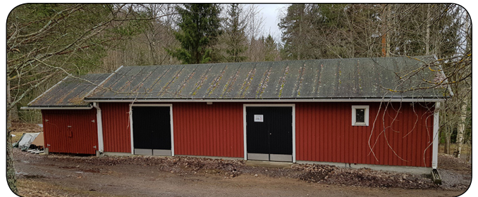
Ulkorakennus pohjoisesta päin kuvattuna.
