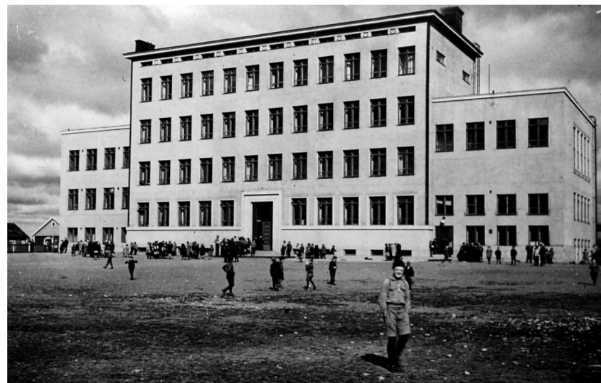
Nekalan koulurakennus vastaavalmistuneena vuonna 1931. Rakennuksen suunnittelija on arkkitehti Bertel Strömmer ja rakentaja rakennustoimisto Niilo Ahti. Kuvälähde: Nekalan koulun rakennushistoriaselvitys (Arkkitehdit A3).
