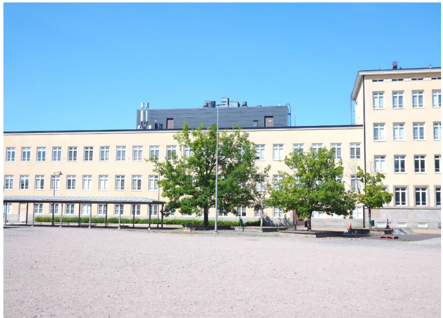
Kuva 6. Osa koulun eteläisestä julkisivusta pihasta katsottuna. Oikealla nelikerroksista alkuperäisosaa, ja vasemmalla kolmikerroksista laajennusta.
