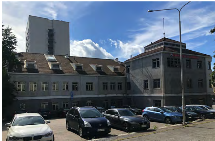
Kuva 49. Sähköliiton talo Satakunnankadulta kuvattuna vuonna 2022.
