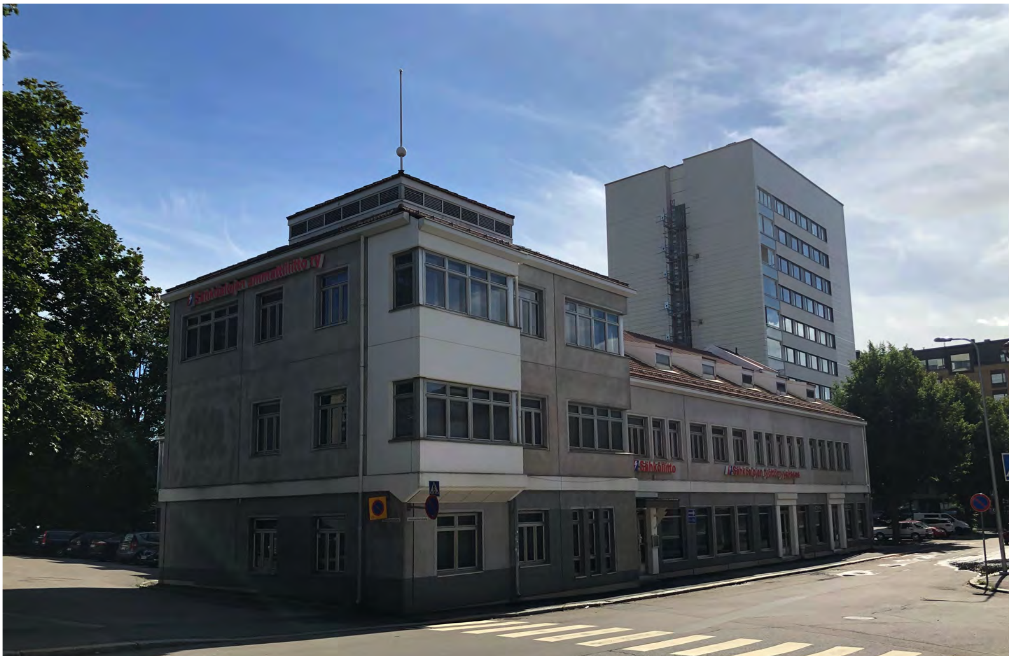
Sähköliiton talo RAKENUSHISTORIALLINEN SELVITYS
