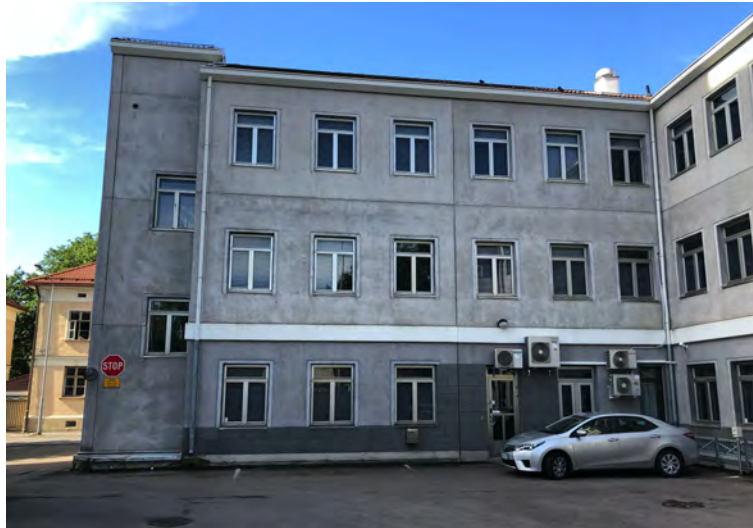
Kuva 50. Sähköliiton talo sisäpihalta kuvattuna vuonna 2022.
