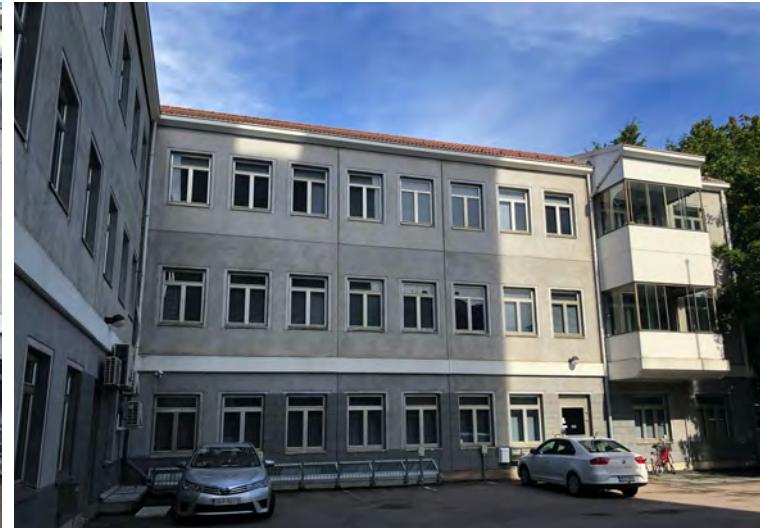
Kuva 53. Sähköliiton talo sisäpihalta kuvattuna vuonna 2022.
