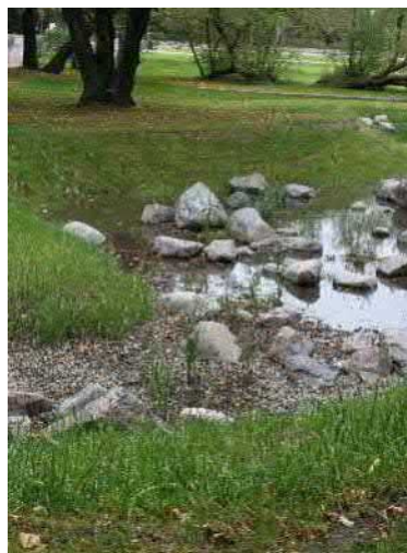
Vauhtien hulevesipainanne, Helsinki. © Seppo Närhi, Kuntatekniikka, 2018
