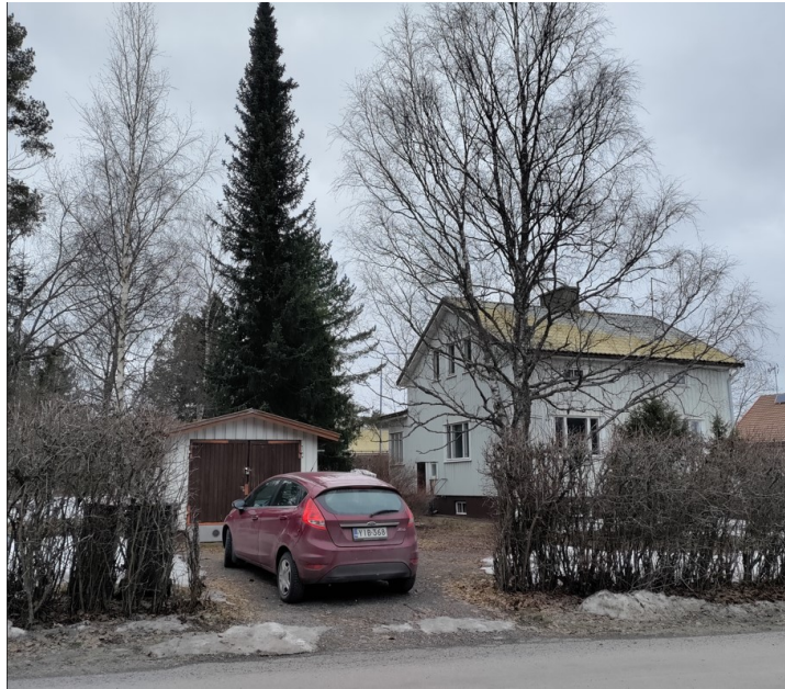
Kuva 1. Näkymä Nurmenkadulta tontille huhtikuussa 2024 ennen rakennusten purkua. © Tampereen kaupunki 2024.
