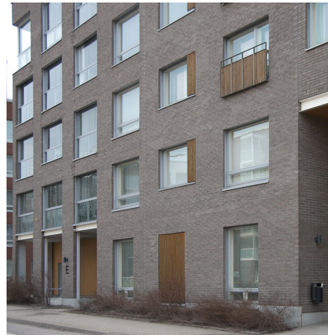
Eri tyyppisiä sisäänvedettyjä parvekkeita kerrostalon katujulkisivulla. Kruunuvuorenranta, Helsinki. Kuva: Tampereen kaupunki (Marjut Lund-Rahkola).
