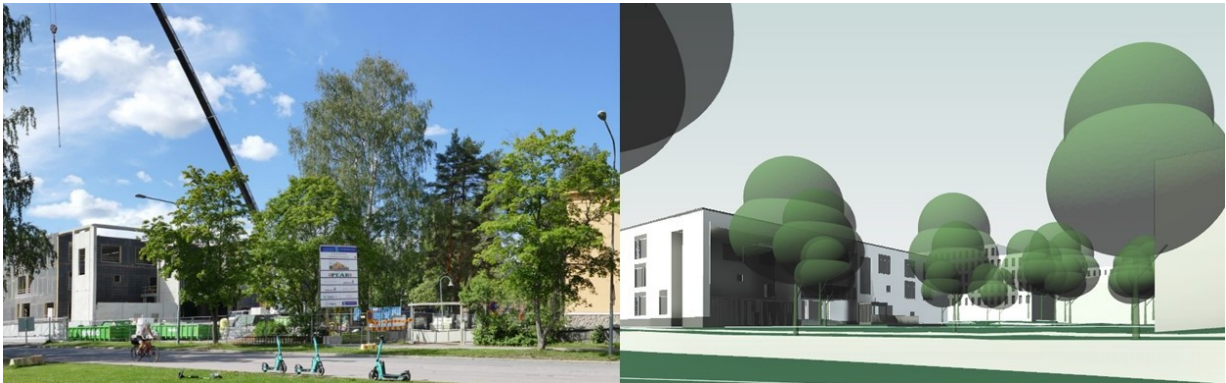
Kuva 10: Kuvapari Eteläpuistosta pohjoiseen päin kuvattuna: vasemmalla valokuvassa Eteläpuiston rakenteilla oleva koulu korttelissa 96 ja oikealla mallikuvassa koulu sekä taustalla uudet asuinrakennukset Kulkutautisairaalan korttelissa 95.
