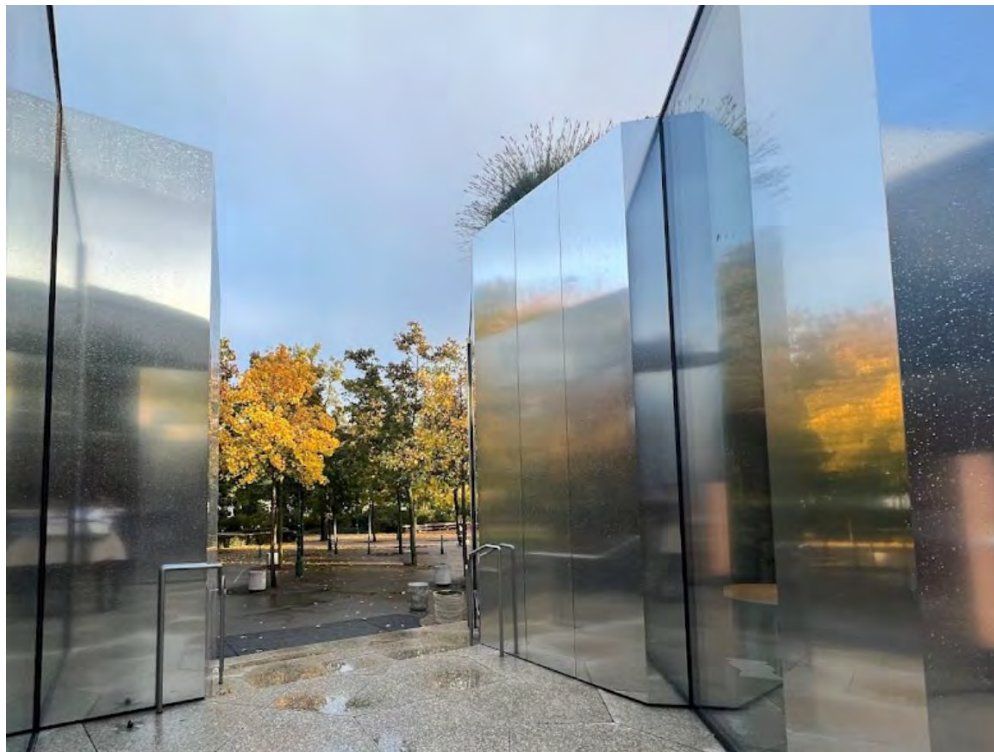
kuva (google maps). Julkisivumateriaalin esimerkki; Am Heumarkt 2A, 1030 Wien, Itävalta.
