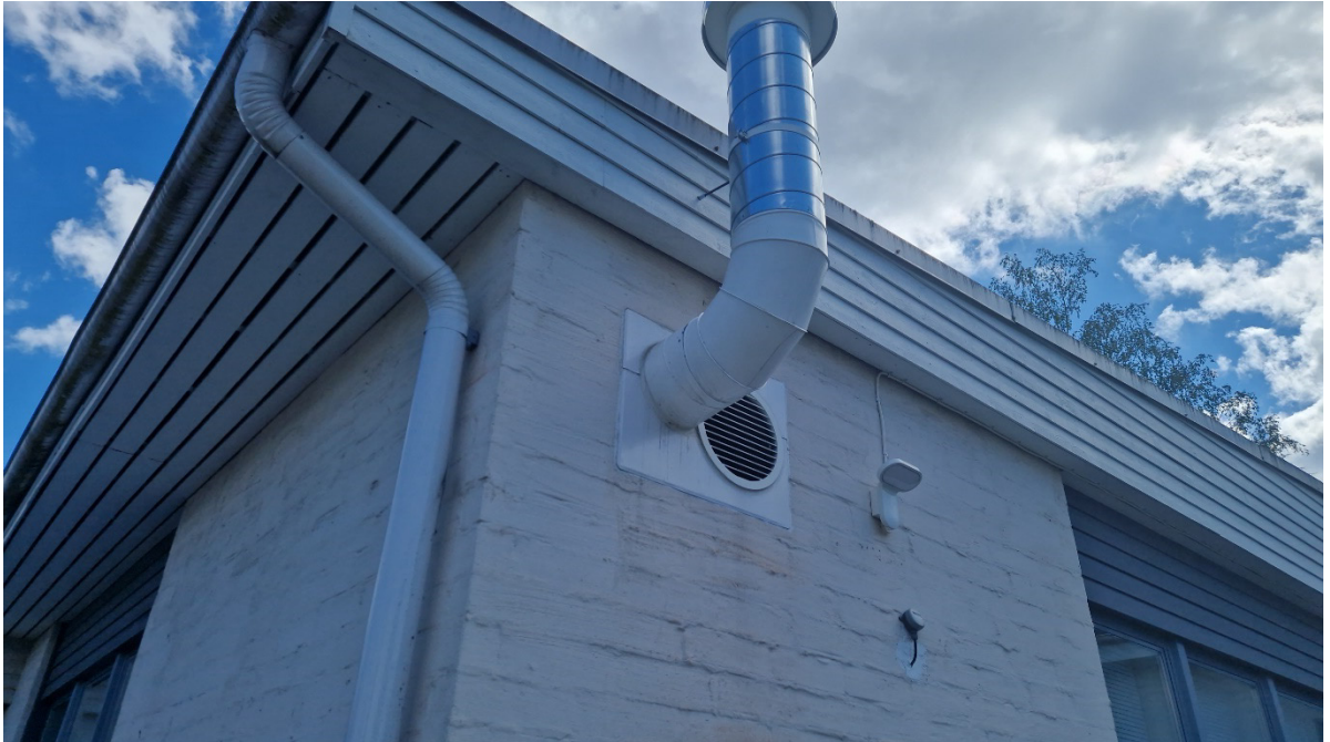
Kuva 4. Seinän tuuletushormi. Osassa hormoneista on verkko, osassa ei. Verkototmat hormit tarkastettiin tarkastuskameralla.
