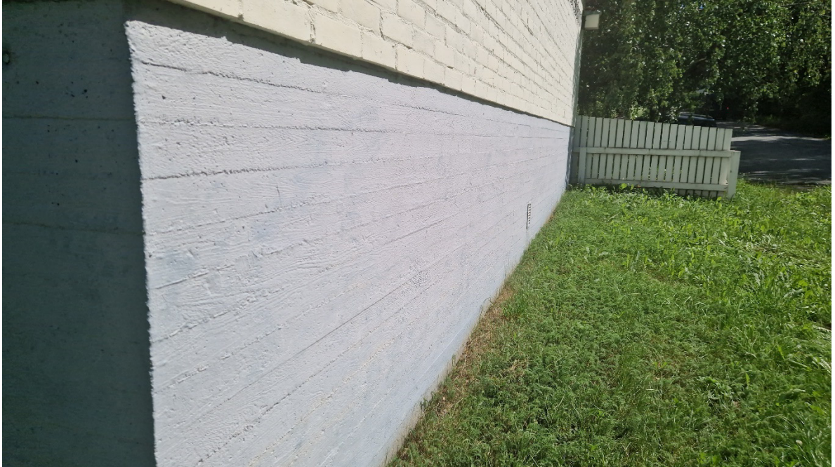
Kuva 2. Rakennuksen perustus on betoninen. Seinä on tiilirakenteinen. Perustuksen ja tiiliseinän saumassa ei ole rakoja.
